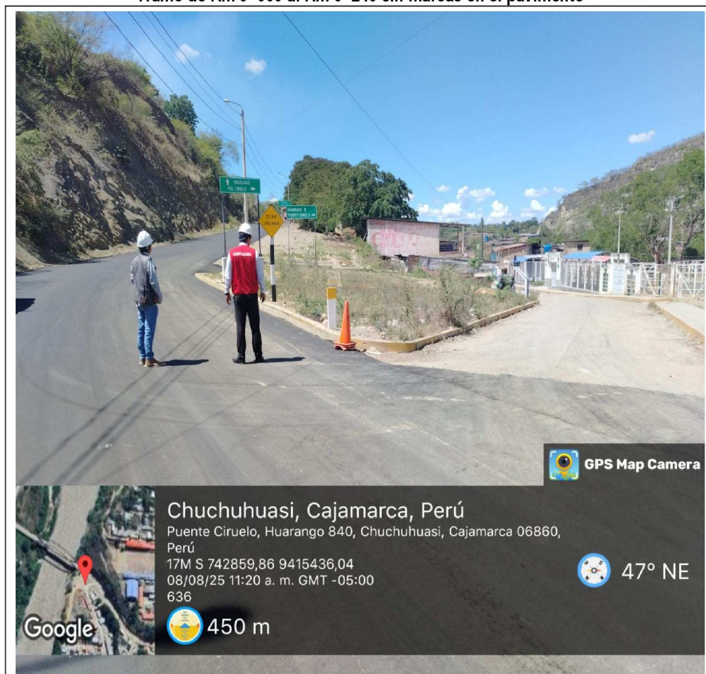
Fotografía n.º 1 Tramo de Km 0+000 al Km 0+240 sin marcas en el pavimento
