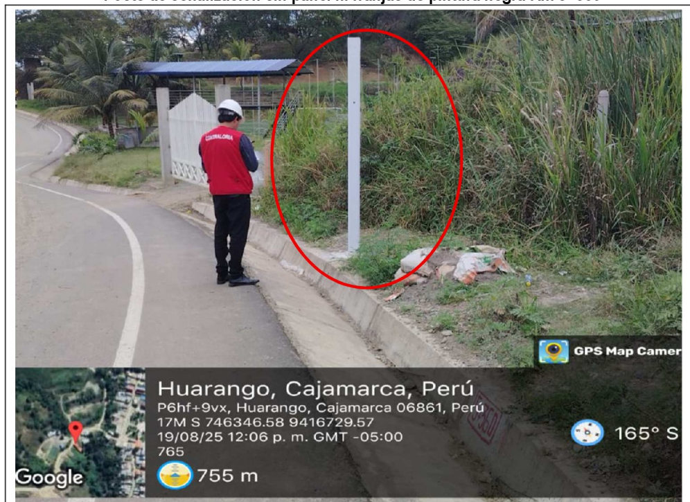
Fotografía n.º 5 Poste de señalización sin panel ni franjas de pintura negra Km 5+360
