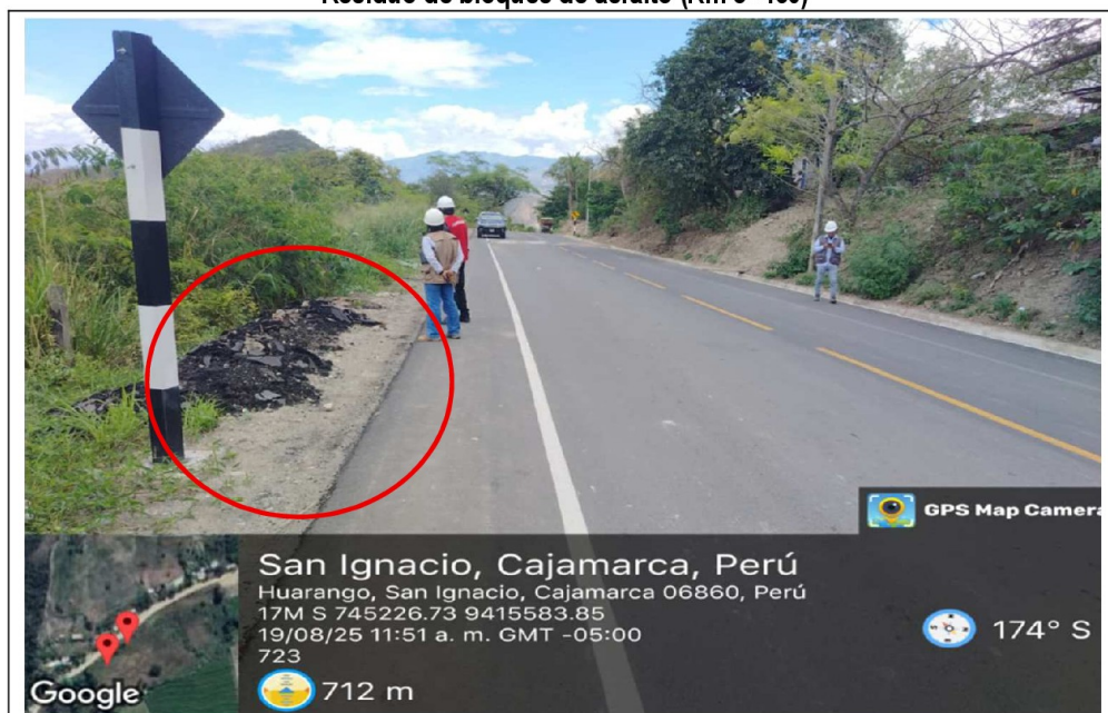
Fotografía n.º 4 Residuo de bloques de asfalto (Km 3+460)
