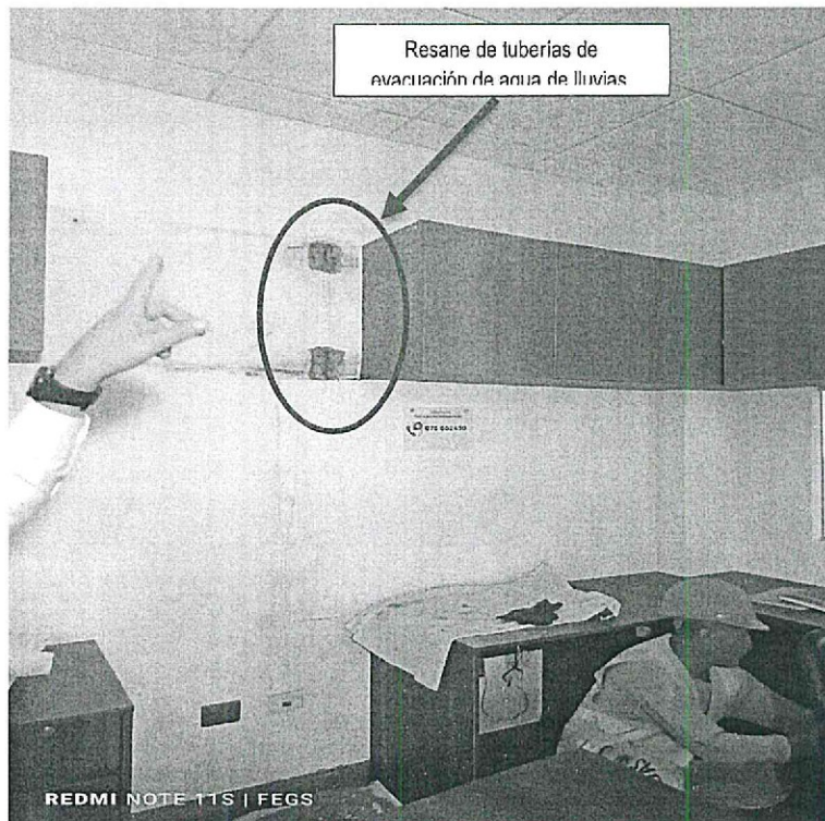
Imagen n.º 7 Resane de tubería de evacuación de agua pluvial
