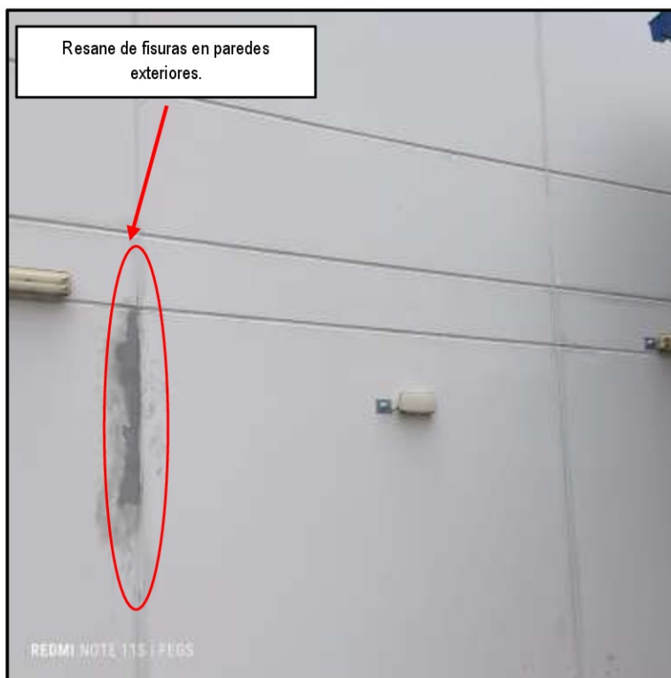
Imagen n.º 8 Resane de fisuras en paredes exteriores
