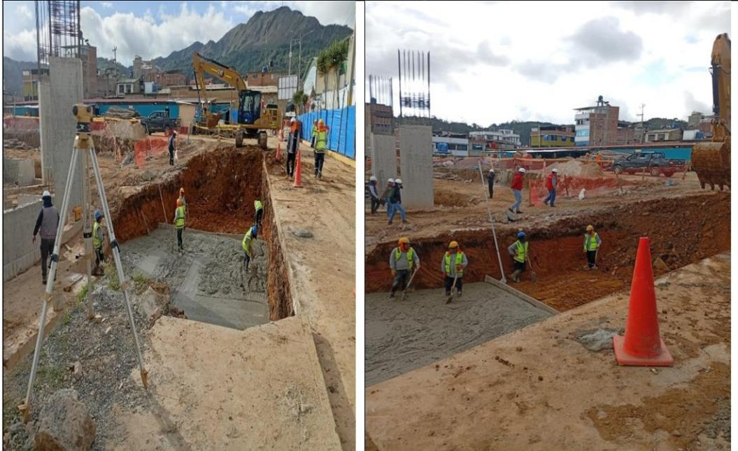
Se puede apreciar no existe una adecuada señalización que podría ocasionar caídas debido a que en la ejecución de los trabajos existe una altura considerable
