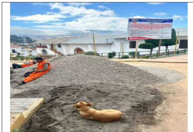
Fotografía n.º 21: Vista del acopio de agregados
