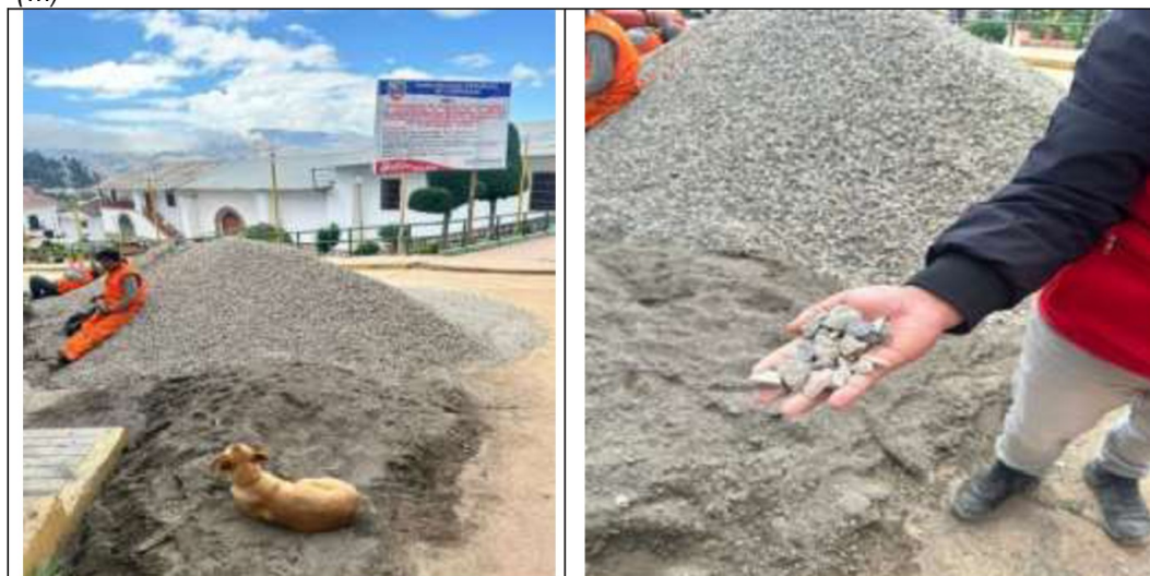
Fotografías N°s 19 y 20: Se aprecia el material agregado utilizado para los trabajos realizados en la ejecución de la obra.
