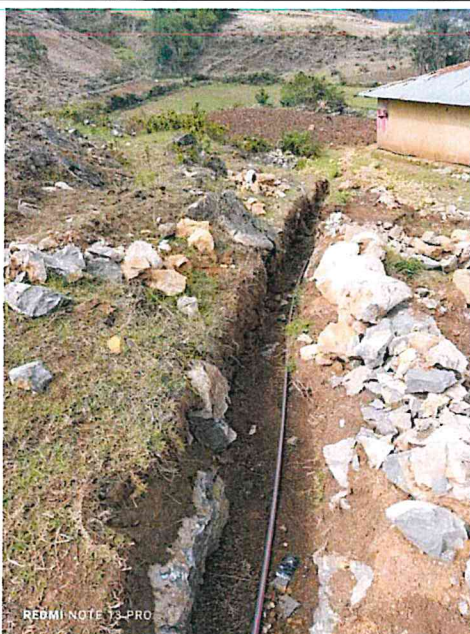
Imagen N° 6 Zanjas abiertas en la línea de distribución de agua Localidad el Porvenir.
