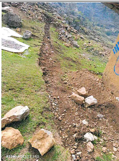
Imagen N° 7 Relleno en redes de distribución de agua Localidad el Porvenir.
