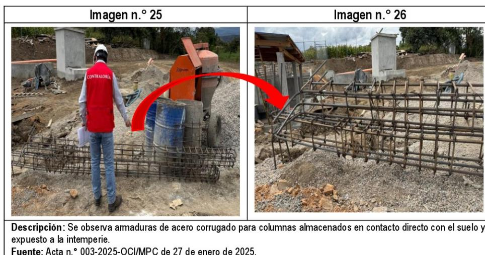
Al respecto, la Norma Técnica E.060 Concreto Armado, precisa que las barras de acero de refuerzo se almacenarán en un lugar seco, aislado del suelo y protegido de la humedad, tierra, sales, aceite y grasas.
