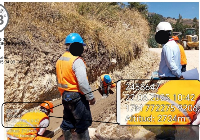
Fotografía n.º 3 del Acta de Inspección Física n.º 1-2025-MPC/OCI-SCC: Personal encontrado realizando encofrado y vaciado de concreto en cunetas (5) en la progresiva km 3+100 aprox.
