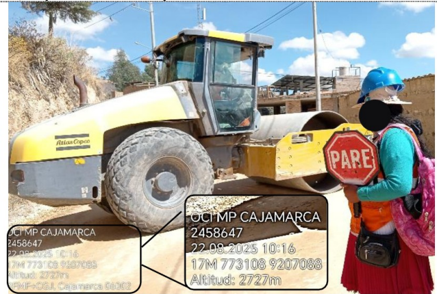
Fotografía n.º 2 del Acta de Inspección Física n.º 1-2025-MPC/OCI-SCC: Rodillo efectuando trabajos, con una viga que controla el tránsito en progresiva km 1+100 aprox.
