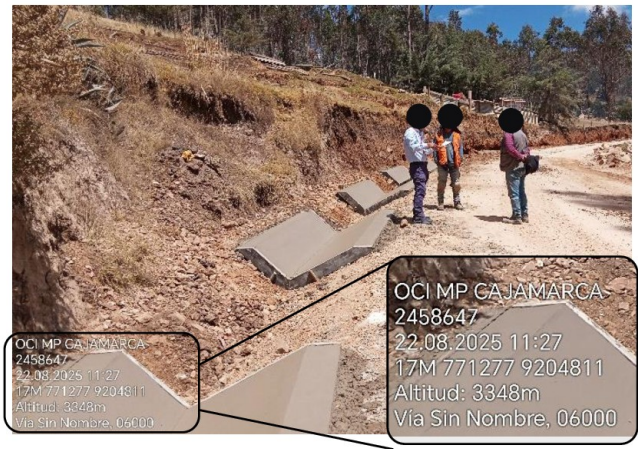
Fotografía n.º 4 del Acta de Inspección Física n.º 1-2025-MPC/OCI-SCC: Se identificó 30 bloques de cunetas con concreto fresco vaciado en km 8+100, se encontró al jefe de grupo de trabajo.
