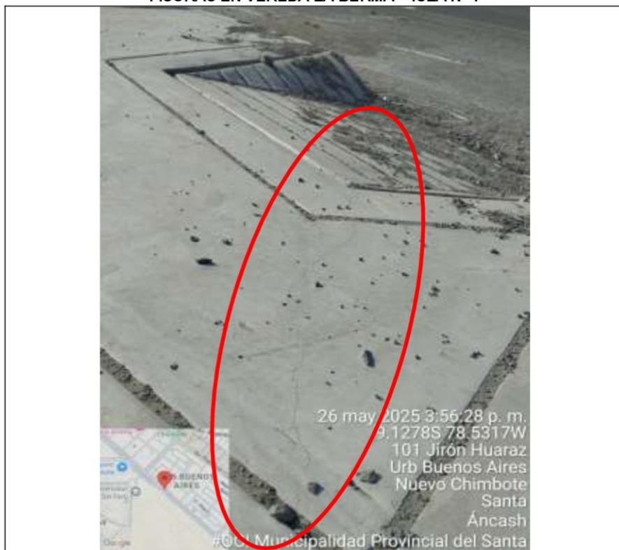
IMAGEN N° 22 FISURAS EN VEREDA LA BERMA – ISLA N° 7
