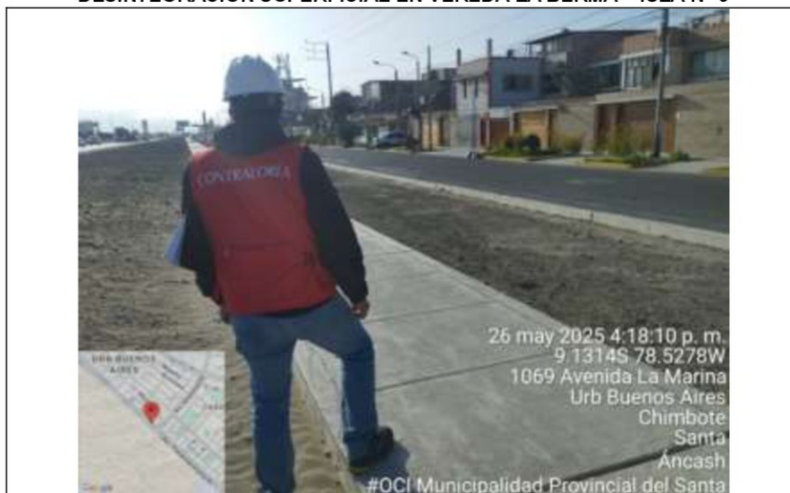
IMAGEN N° 26 DESINTEGRACIÓN SUPERFICIAL EN VEREDA LA BERMA – ISLA N° 9
