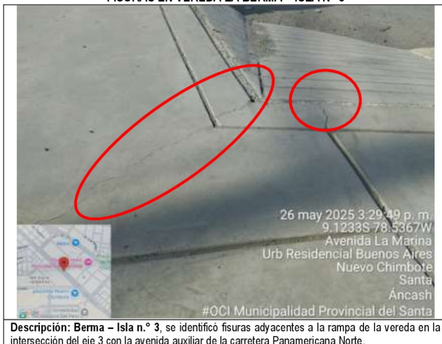
IMAGEN N° 19 FISURAS EN VEREDA LA BERMA – ISLA N° 3
