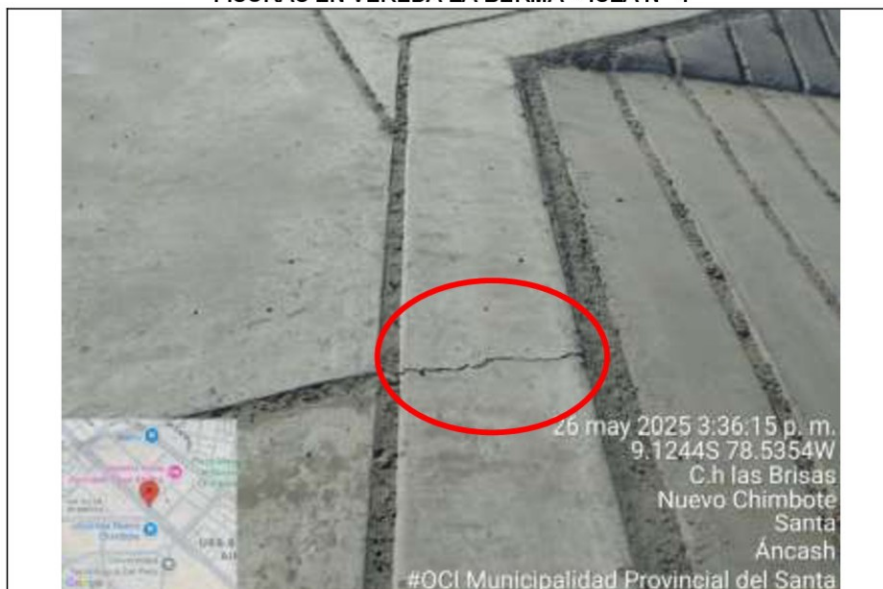
IMAGEN N° 20 FISURAS EN VEREDA LA BERMA – ISLA N° 4
