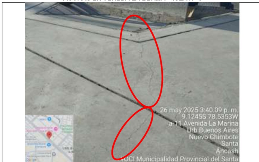
IMAGEN N° 21 FISURAS EN VEREDA LA BERMA – ISLA N° 5
