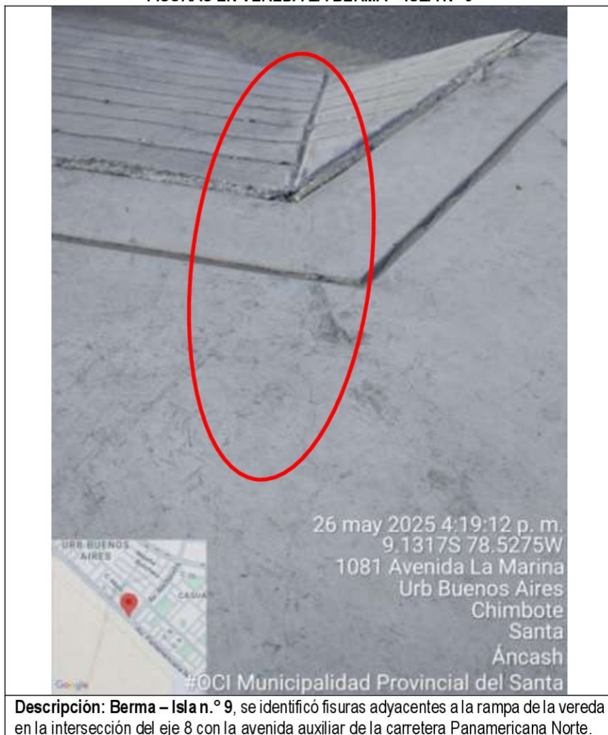
IMAGEN N° 25 FISURAS EN VEREDA LA BERMA – ISLA N° 9
