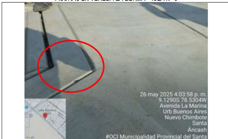
IMAGEN N° 23 FISURAS EN VEREDA LA BERMA – ISLA N° 8
