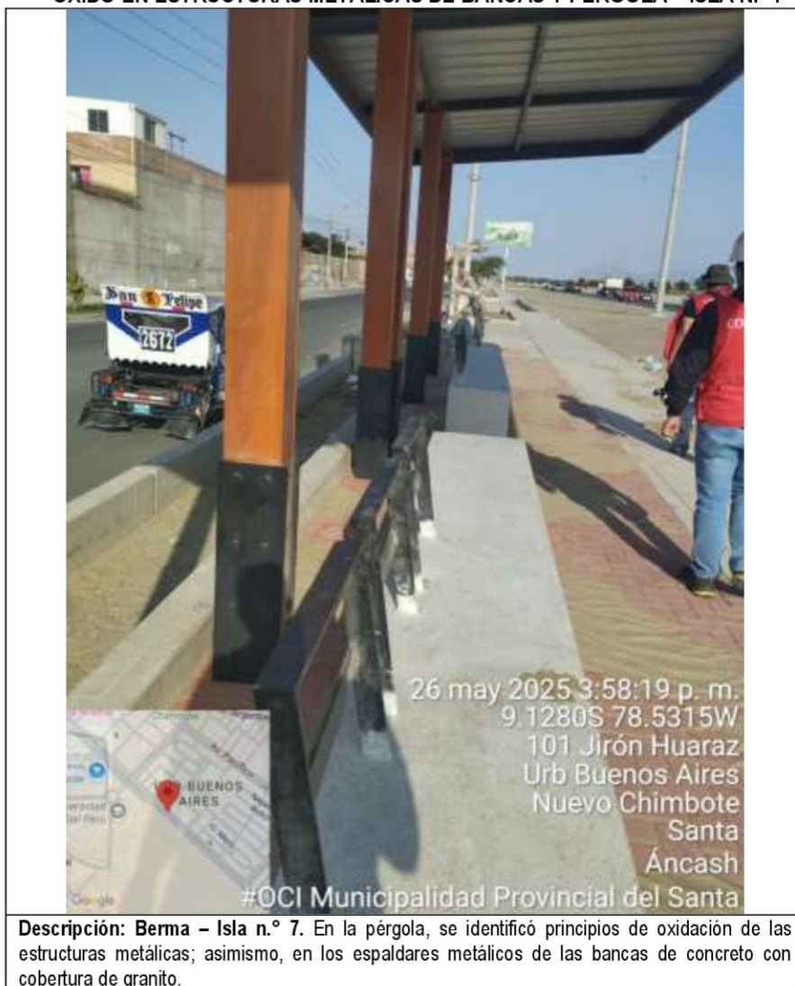
IMAGEN N° 40 ÓXIDO EN ESTRUCTURAS METÁLICAS DE BANCAS Y PÉRGOLA – ISLA N.º 7
