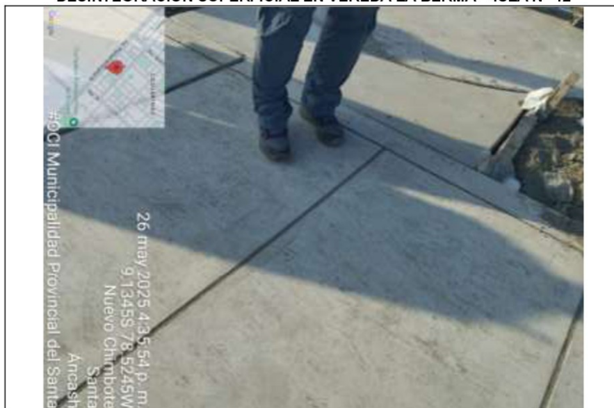
IMAGEN N° 27 DESINTEGRACIÓN SUPERFICIAL EN VEREDA LA BERMA – ISLA N° 12
