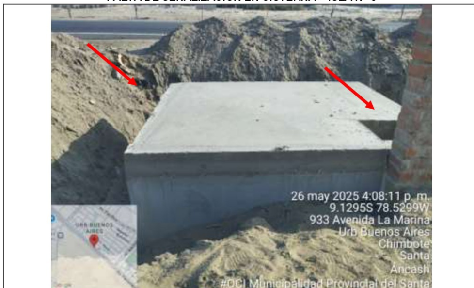
IMAGEN N° 46 FALTA DE SEÑALIZACIÓN EN CISTERNA – ISLA N° 8
