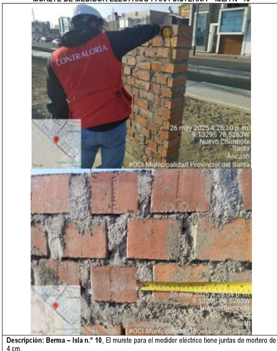
IMÁGENES N.ºS 36 Y 37 MURETE DE MEDIDOR ELÉCTRICO PARA CISTERNA – ISLA N.º 10
