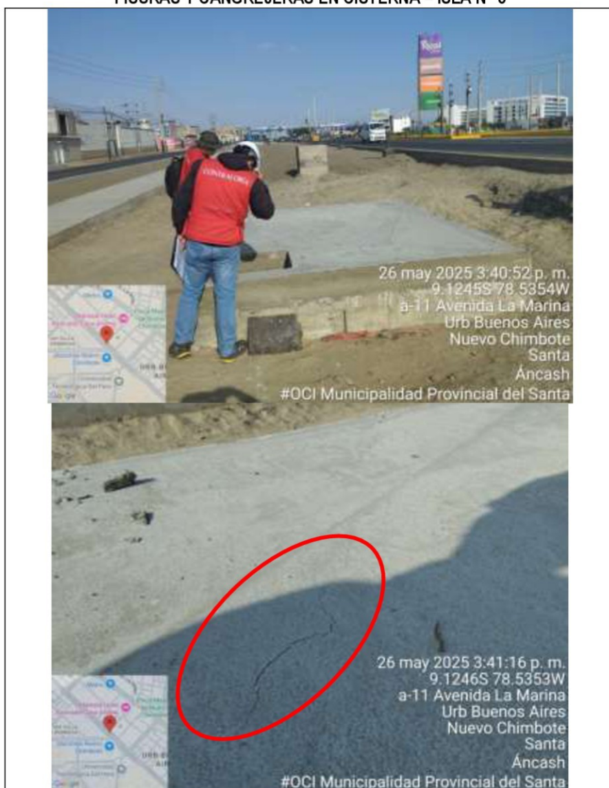
IMÁGENES N.ºS 30, 31 Y 32 FISURAS Y CANGREJERAS EN CISTERNA – ISLA N.º 5
