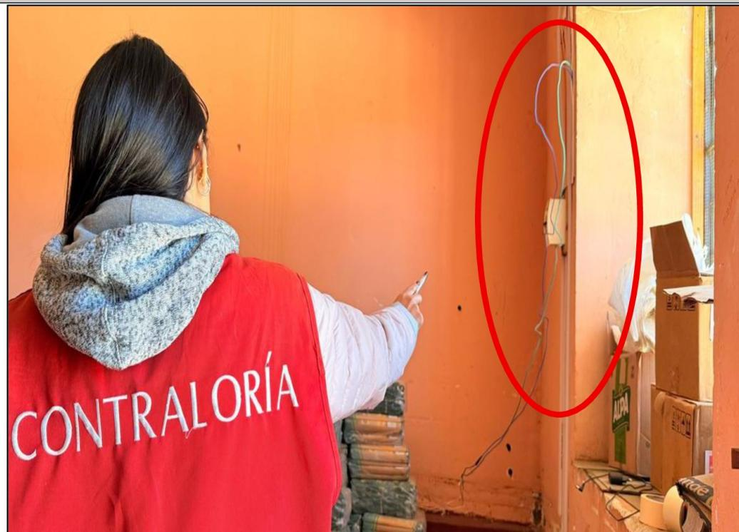
**Descripción:** Se evidencia la presencia de cables de electricidad expuestos sin canalización adecuada.
