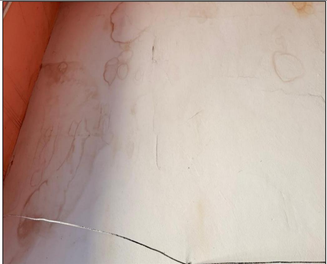
**Descripción:** Se evidencia techo con presencia de humedad proveniente de lluvias y/o agua. Las manchas se extienden desde el techo hacia abajo, indicando posibles filtraciones desde la parte superior
