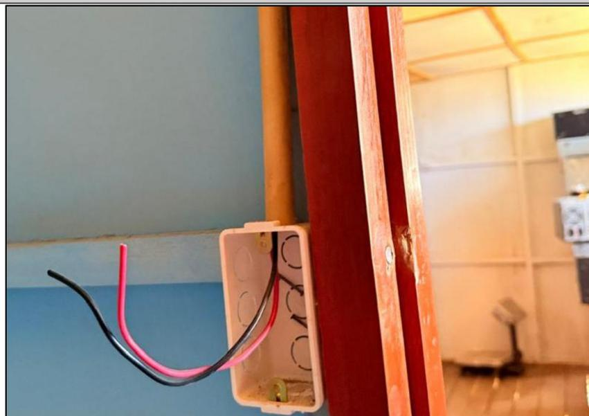
**Descripción:** Se evidencia en el almacén, la presencia de cables de electricidad expuestos sin instalación eléctrica.
