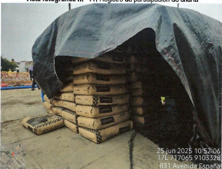
Vista fotográfica n.º 12: Cemento tipo V presente en el frente de trabajo en la intersección de la Av. España y Jr. Gamarra
