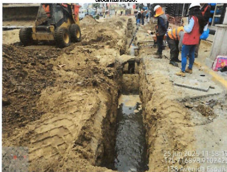
Vista fotográfica n.º 54: Presencia de agua residuales en la zanja donde se realiza la colocación de la cama de arena, en la avenida España en el tramo entre la calle Marcelo Come y Av. Larco, correspondiente a la línea de alcantarillado.
