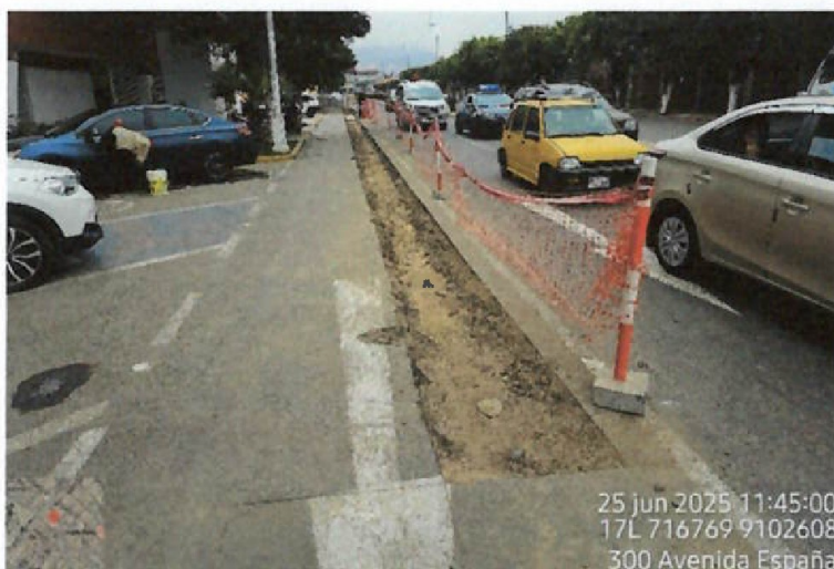
Vista fotográfica n.º 40: Corte y demolición del pavimento existente realizado en la avenida España en el tramo entre la calle Torre Tagle y Jr. San Martín, correspondiente a la línea de alcantarillado.
