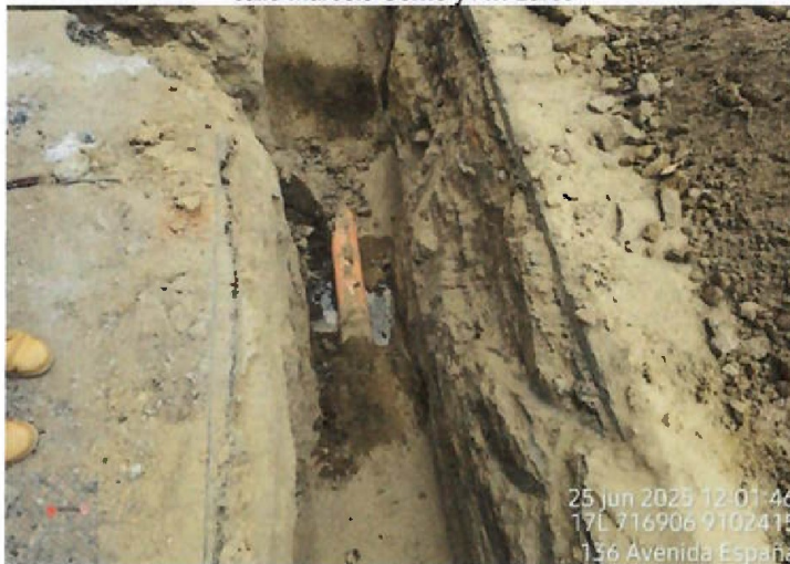
Vista fotográfica n.º 59: Presencia de aguas residuales en la zanja en avenida España en el tramo entre la calle Marcelo Corne y Av. Larco
