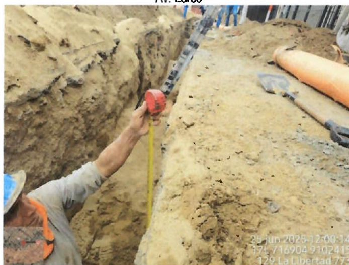
Vista fotográfica n.º 57: Profundidad de zanja medido desde la clave de la tubería de PVC instalada es de 1,80 m en avenida España en el tramo entre la calle Marcelo Come y Av. Larco
