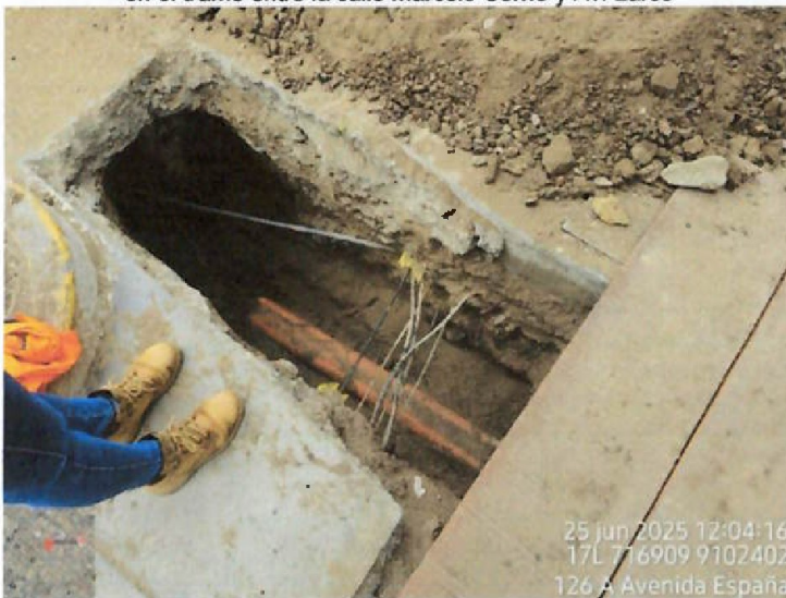
Vista fotográfica n.º 62: Redes existentes en zona de excavación para conexiones domiciliarias en avenida España en el tramo entre la calle Marcelo Corne y Av. Larco
