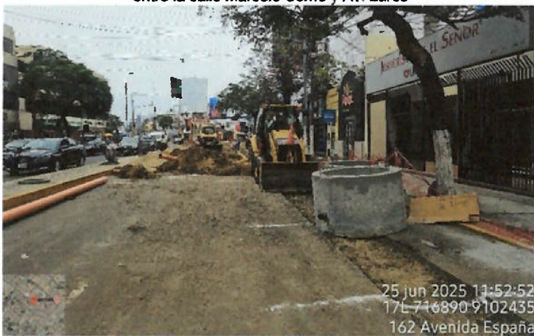
Vista fotográfica n.º 51: Trabajos de excavación de zanja con retroexcavadora realizado en la avenida España en el tramo entre la calle Marcelo Come y Av. Larco, correspondiente a la línea de alcantarillado.
