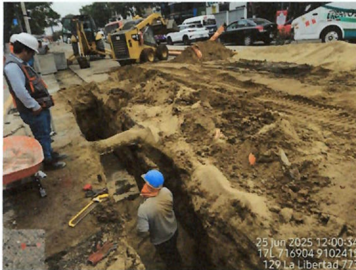
Vista fotográfica n.º 58: Trabajos de colocación de arena fina en la zanja en avenida España en el tramo entre la calle Marcelo Corne y Av. Larco
