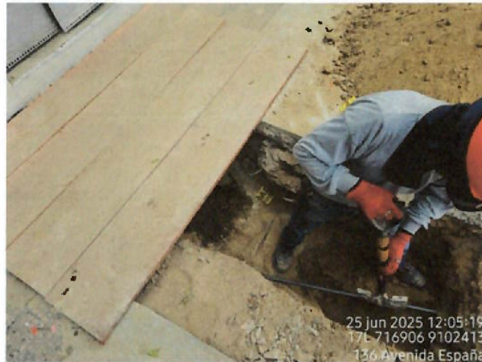
Vista fotográfica n.º 64: Redes existentes en zona de excavación para conexiones domiciliarias en avenida España en el tramo entre la calle Marcelo Come y Av. Larco
