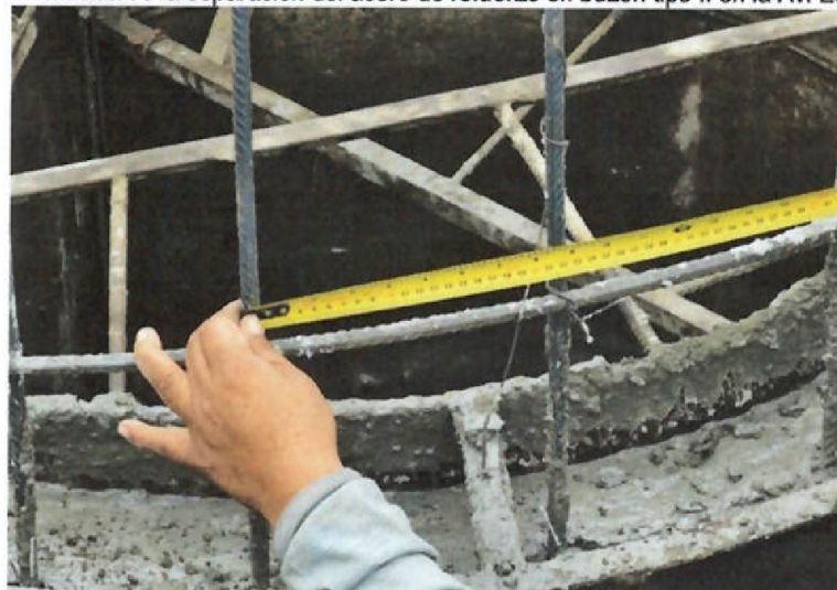
Vista fotográfica n.º 9: Medida de la separación del acero de refuerzo en buzón tipo II en la Av. España con Jr. Gamarra
