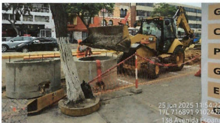
Vista fotográfica n.º 52: Traslado de los cuerpos de buzón con una retroexcavadora en la avenida España en el tramo entre la calle Marcelo Come y Av. Larco, correspondiente a la línea de alcantarillado.
