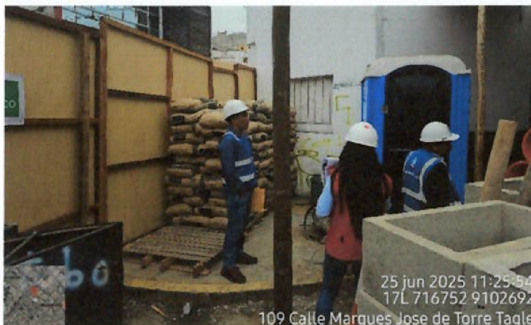
Vista fotográfica n.º 28: Interior del almacén de obra, en donde se evidencia, entre otros, un servicio higiénico portátil, bolsas de cemento tipo V, cajas de desagüe.
