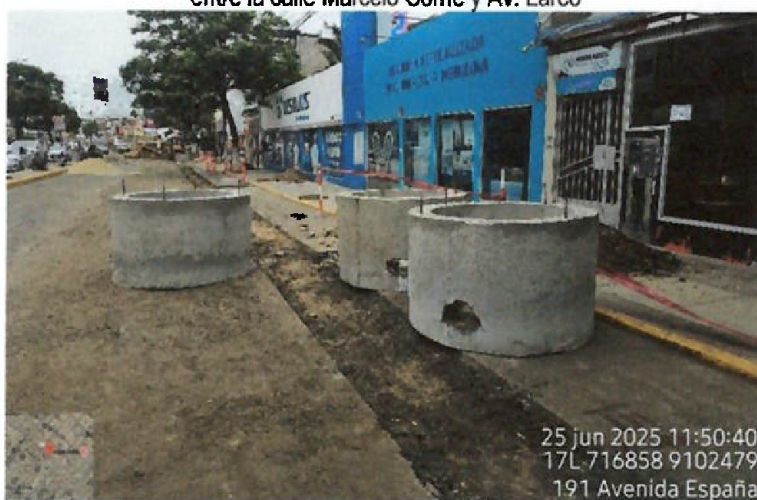
Vista fotográfica n.º 48: Cuerpos de buzones para su próxima instalación en la avenida España en el tramo entre la calle Marcelo Come y Av. Larco
