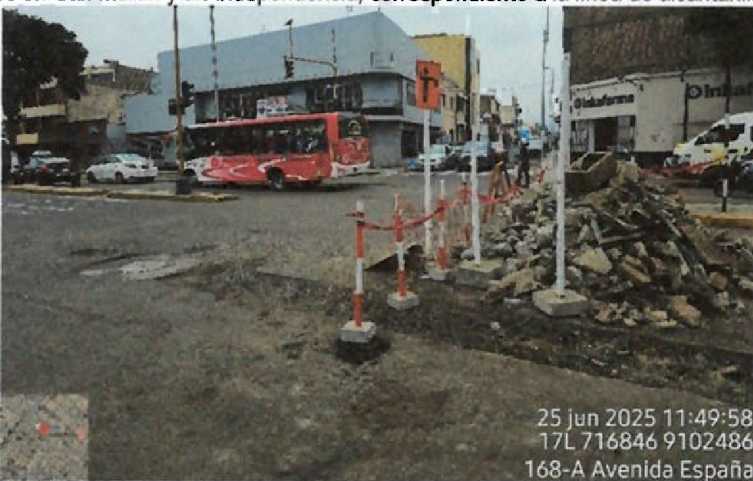
Vista fotográfica n.º 45: Corte y demolición del pavimento existente realizado en la avenida España en el tramo entre la calle Marcelo Come y Av. Larco, correspondiente a la línea de alcantarillado; asimismo, se evidenció material excedente producto de los trabajos de demolición
