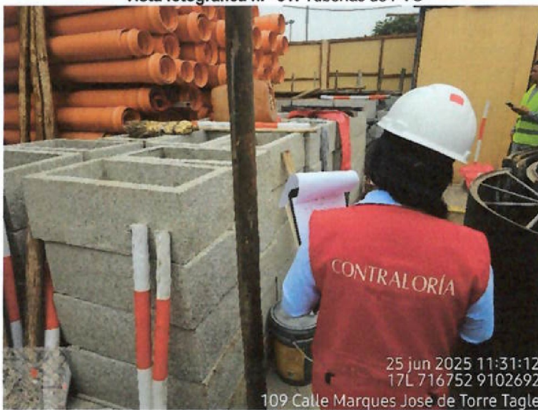
Vista fotográfica n.º 32: Cajas de desagüe
