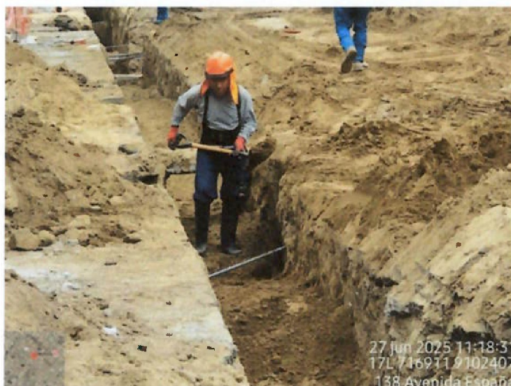
Vista fotográfica n.º 46: Relleno con material propio en zanja de la línea de alcantarillado de PVC de 200 mm en la Av. España entre la calle Marcelo Come y Av Larco
