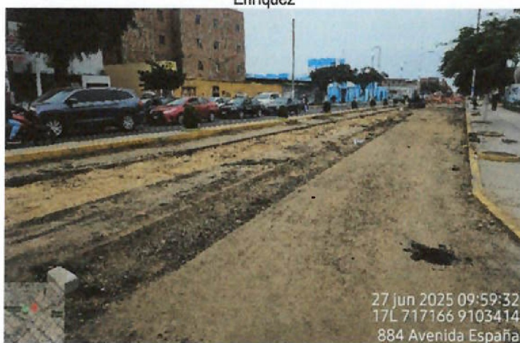
Vista fotográfica n.º 17: Pavimento existente demolido en la Av. España entre Jr Gamarra y Av. Manuel Vera Enríquez
