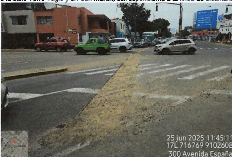
Vista fotográfica n.º 41: Corte y demolición del pavimento existente realizado en la avenida España en el tramo entre Jr. San Martín y Jr. Independencia, correspondiente a la línea de alcantarillado.
