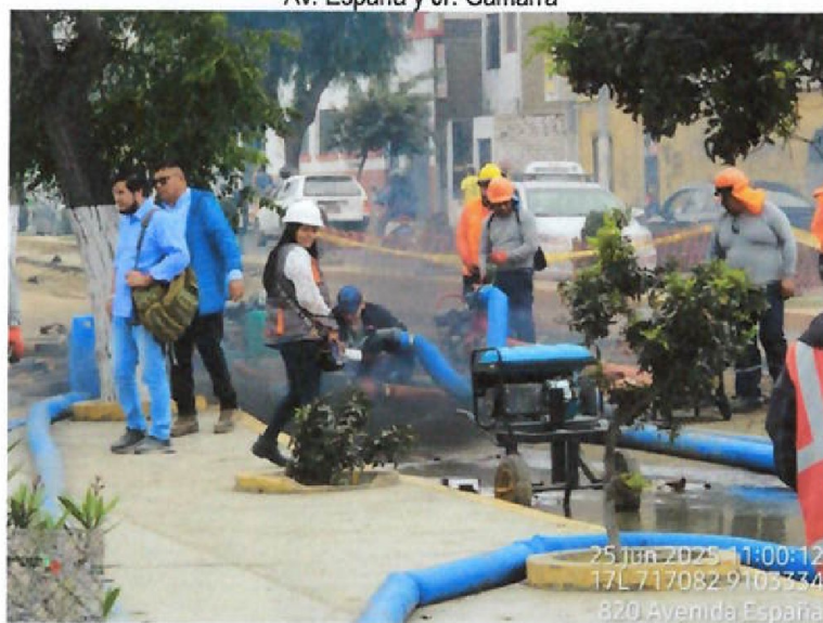
Vista fotográfica n.º 15: Emisión de humo negro proveniente de la motobomba utilizada en el frente de trabajo en la intersección de la Av. España y Jr. Gamarra
