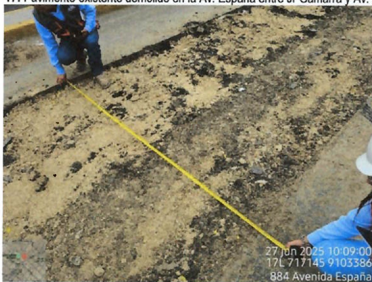
Vista fotográfica n.º 18: Pavimento existente demolido, con un ancho de corte entre 2,00 y 3,00 m en la Av. España entre Jr Gamarra y Av. Manuel Vera Enríquez
