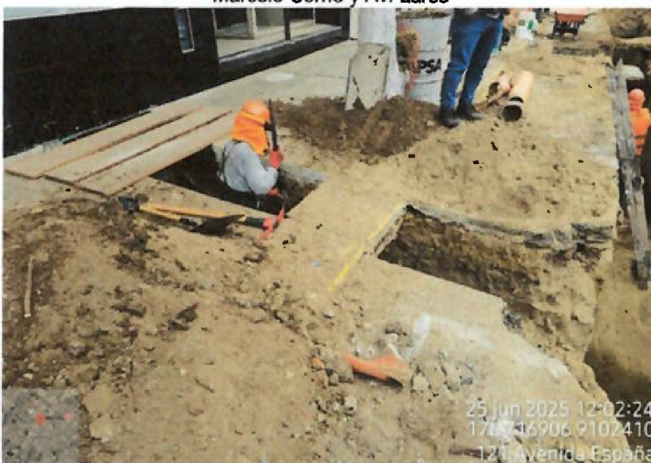
Vista fotográfica n.º 60: Trabajos de excavación para conexiones domiciliarias en avenida España en el tramo entre la calle Marcelo Corne y Av. Larco
