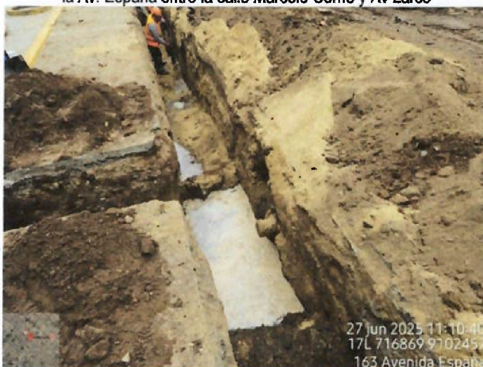
Vista fotográfica n.º 35: Presencia de aguas residuales en la zanja para la línea de alcantarillado de PVC de 200 mm en la Av. España entre la calle Marcelo Come y Av Larco
