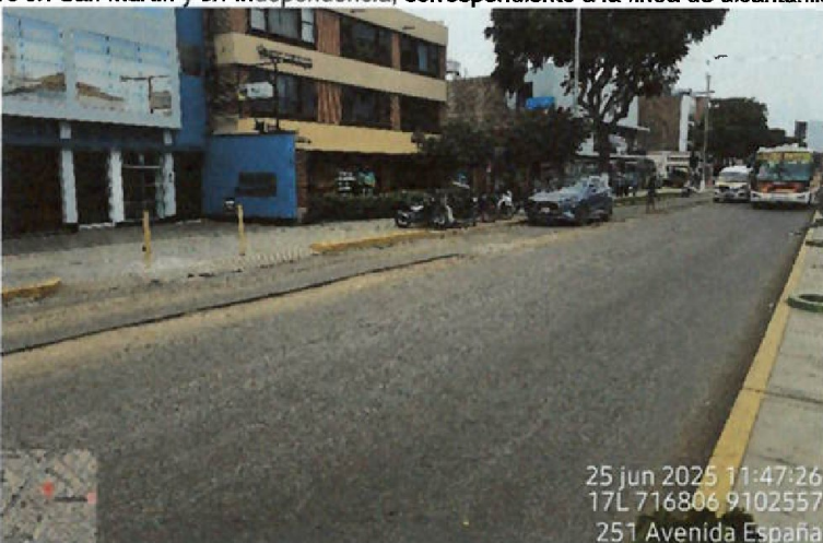
Vista fotográfica n.º 42: Corte y demolición del pavimento existente realizado en la avenida España en el tramo entre Jr. San Martín y Jr. Independencia, correspondiente a la línea de alcantarillado.
