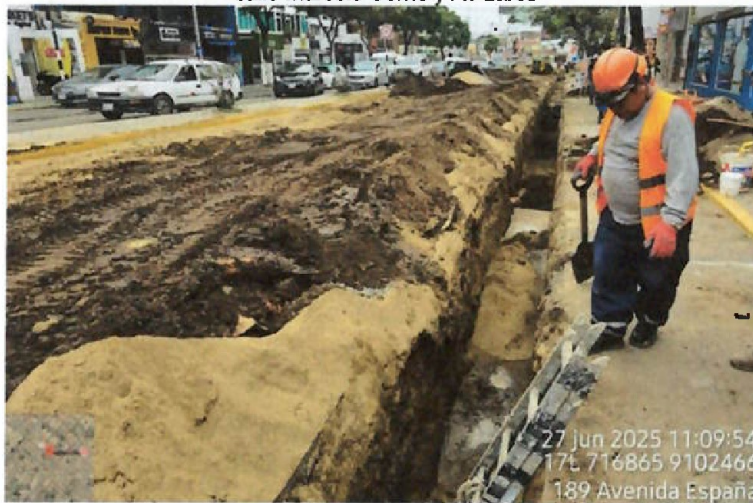
Vista fotográfica n.º 29: Presencia de aguas residuales en la zanja para la línea de alcantarillado de PVC de 200 mm en la Av. España entre la calle Marcelo Come y Av Larco
