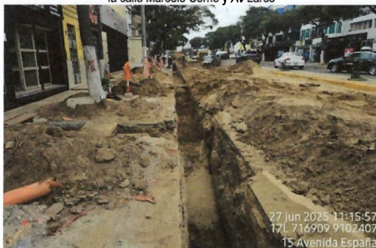
Vista fotográfica n.º 44: Zanja de la línea de alcantarillado de PVC de 200 mm en la Av. España entre la calle Marcelo Corne y Av Larco
