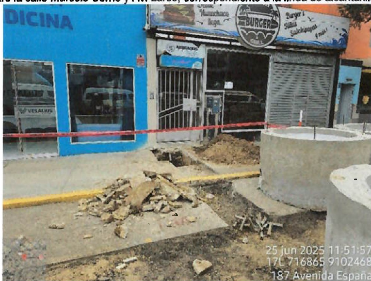
Vista fotográfica n.º 50: Trabajos de excavación para conexiones domiciliarias en la avenida España en el tramo entre la calle Marcelo Come y Av. Larco
