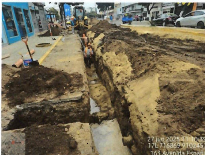
Vista fotográfica n.º 34: Presencia de aguas residuales en la zanja para la línea de alcantarillado de PVC de 200 mm en la Av. España entre la calle Marcelo Come y Av Larco
