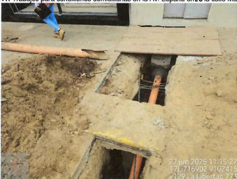
Vista fotográfica n.º 42: Trabajos para conexiones domiciliarias en la Av. España entre la calle Marcelo Corne y Av Larco
