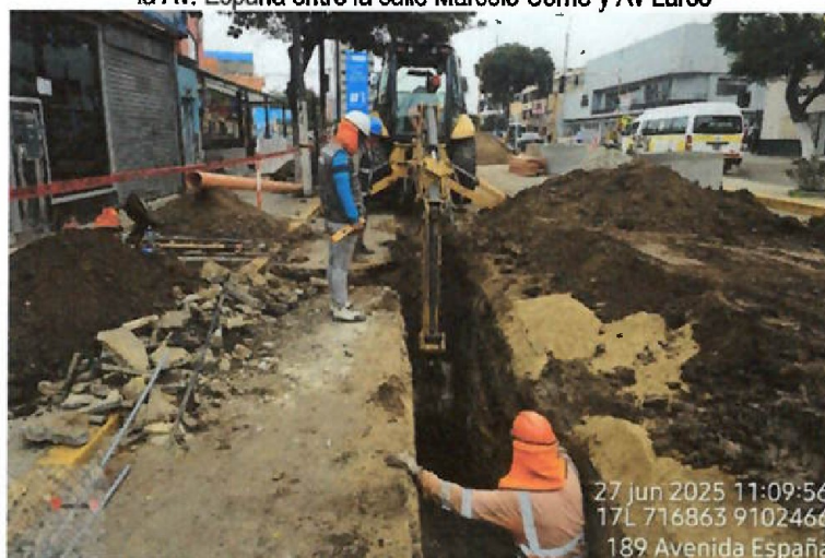
Vista fotográfica n.º 30: Excavación para línea de alcantarillado de PVC de 200 mm en la Av. España entre la calle Marcelo Come y Av Larco
