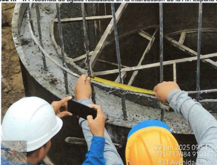
Vista fotográfica n.º 5: Medida de la separación del acero de refuerzo en buzón tipo II en la Av. España con Jr. Gamarra
