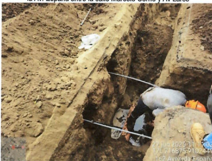
Vista fotográfica n.º 36: Presencia de aguas residuales en la zanja para la línea de alcantarillado de PVC de 200 mm en la Av. España entre la calle Marcelo Come y Av Larco
