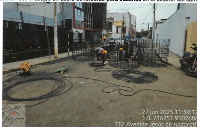
Vista fotográfica n.º 51: Trabajos en acero de refuerzo para buzones en el exterior del campamento de obra
