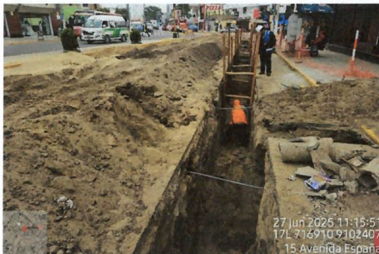
Vista fotográfica n.º 43: Tablestacado para zanja de la línea de alcantarillado de PVC de 200 mm en la Av. España entre la calle Marcelo Corne y Av Larco
