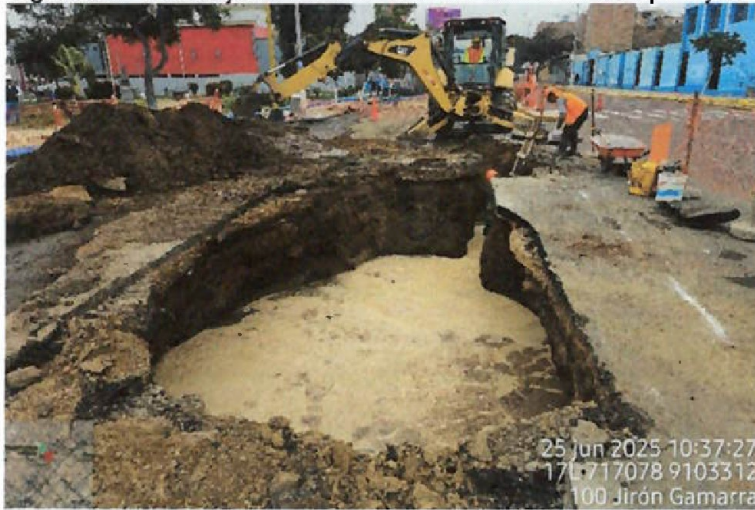
Vista fotográfica n.º 8: Presencia de aguas residuales en la zona de trabajo de la intersección de la Av. España y Jr. Gamarra
