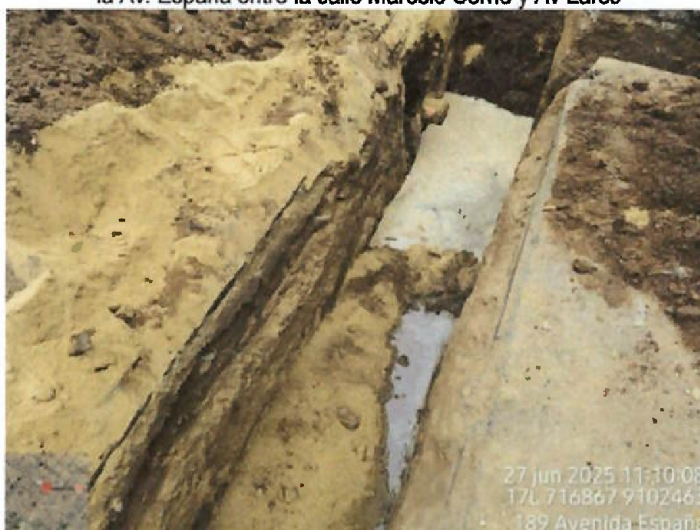
Vista fotográfica n.º 33: Presencia de aguas residuales en la zanja para la línea de alcantarillado de PVC de 200 mm en la Av. España entre la calle Marcelo Come y Av Larco
