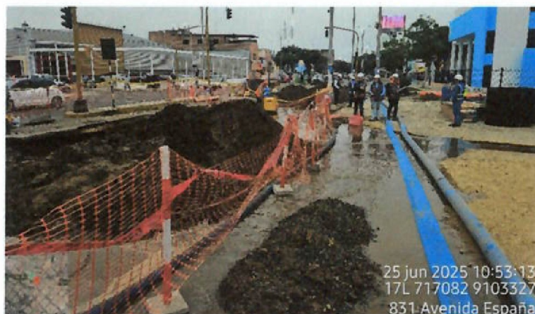
Vista fotográfica n.º 13: Presencia de aguas residuales producto del aniego producido en la intersección de la Av. España y Jr. Gamarra
