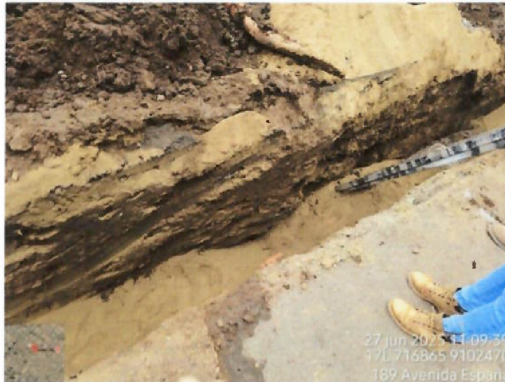
Vista fotográfica n.º 28: Colocación de arena para línea de alcantarillado de PVC de 200 mm en la Av. España entre la calle Marcelo Come y Av Larco
