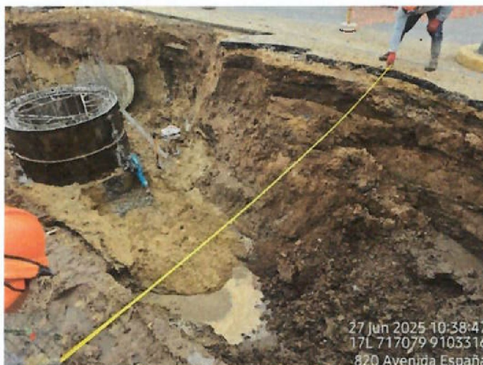
Vista fotográfica n.º 22: Forado en la Av. España contiguo a la intersección con Jr Gamarra
