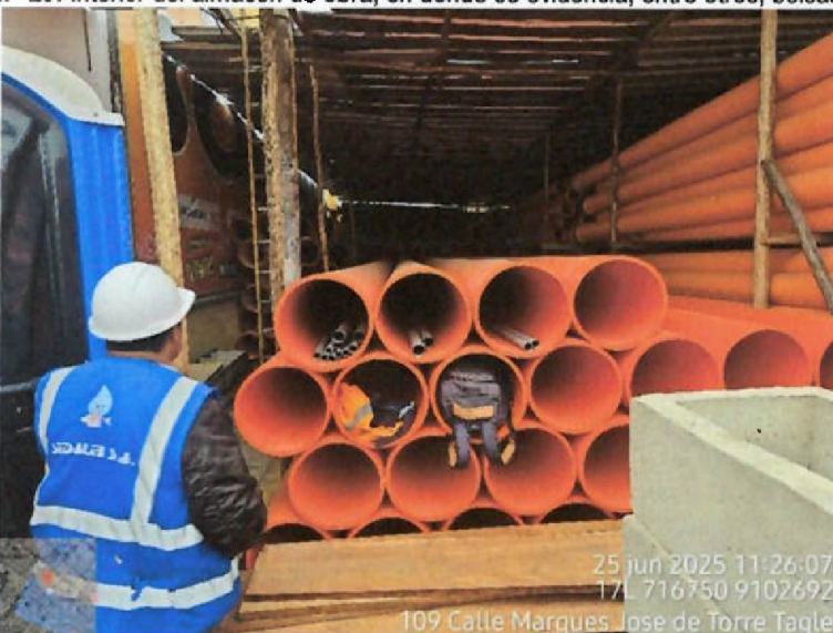
Vista fotográfica n.º 30: Tuberías HDPE de 400 mm x 15,30 mm y tuberías de PVC de 200 mm x 4,90 mm
