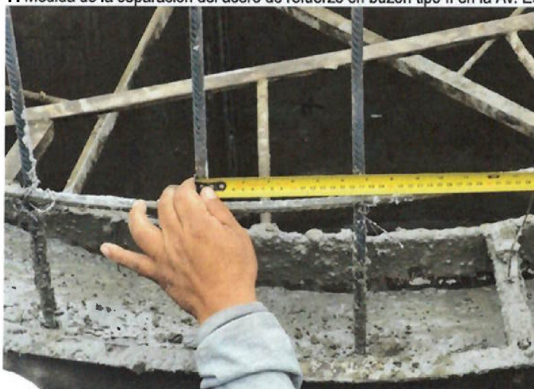
Vista fotográfica n.º 8: Medida de la separación del acero de refuerzo en buzón tipo II en la Av. España con Jr. Gamarra
