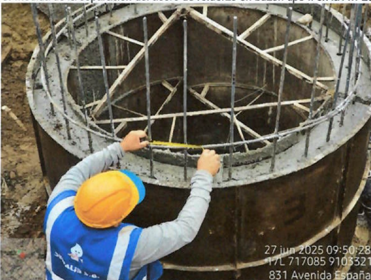
Vista fotográfica n.º 6: Medida de la separación del acero de refuerzo en buzón tipo II en la Av. España con Jr. Gamarra
