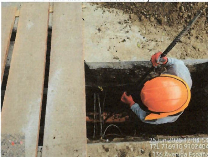
Vista fotográfica n.º 63: Redes existentes en zona de excavación para conexiones domiciliarias en avenida España en el tramo entre la calle Marcelo Corne y Av. Larco
