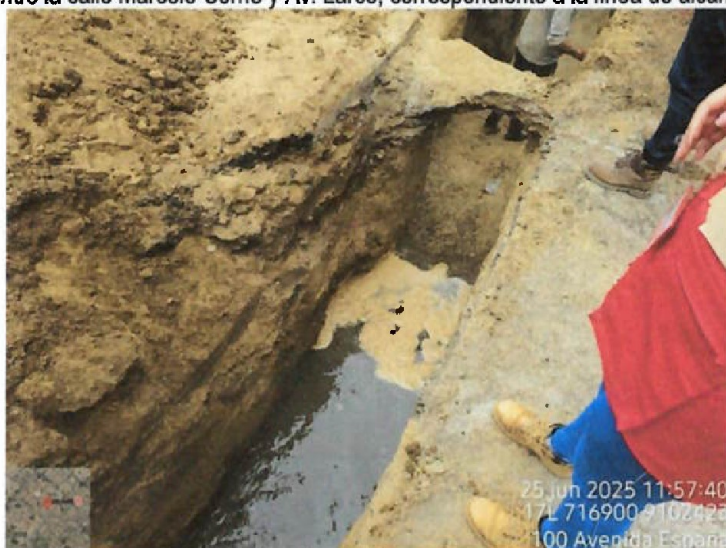
Vista fotográfica n.º 53: Presencia de agua residuales en la zanja donde se realiza la colocación de la cama de arena, en la avenida España en el tramo entre la calle Marcelo Come y Av. Larco, correspondiente a la línea de alcantarillado.
