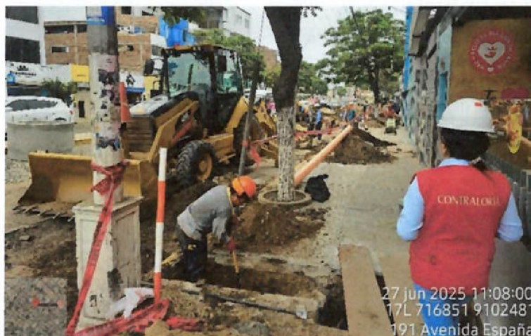
Vista fotográfica n.º 25: Excavación para conexiones domiciliarias en la Av. España entre la calle Marcelo Corne y Av Larco
