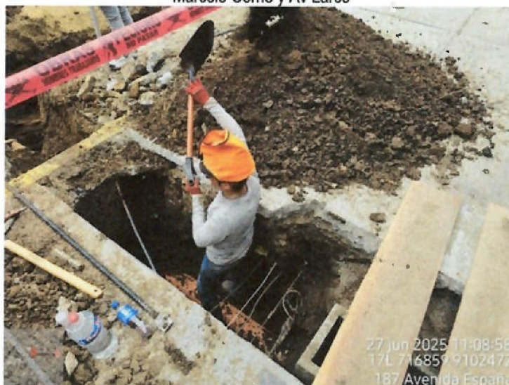
Vista fotográfica n.º 27: Excavación para conexiones domiciliarias en la Av. España entre la calle Marcelo Corne y Av Larco
