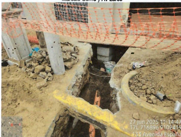
Vista fotográfica n.º 41: Trabajos para conexiones domiciliarias en la Av. España entre la calle Marcelo Corne y Av Larco
