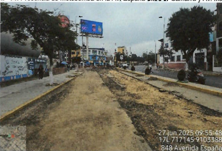
Vista fotográfica n.º 15: Pavimento existente demolido en la Av. España entre Jr Gamarra y Av. Manuel Vera Enríquez
