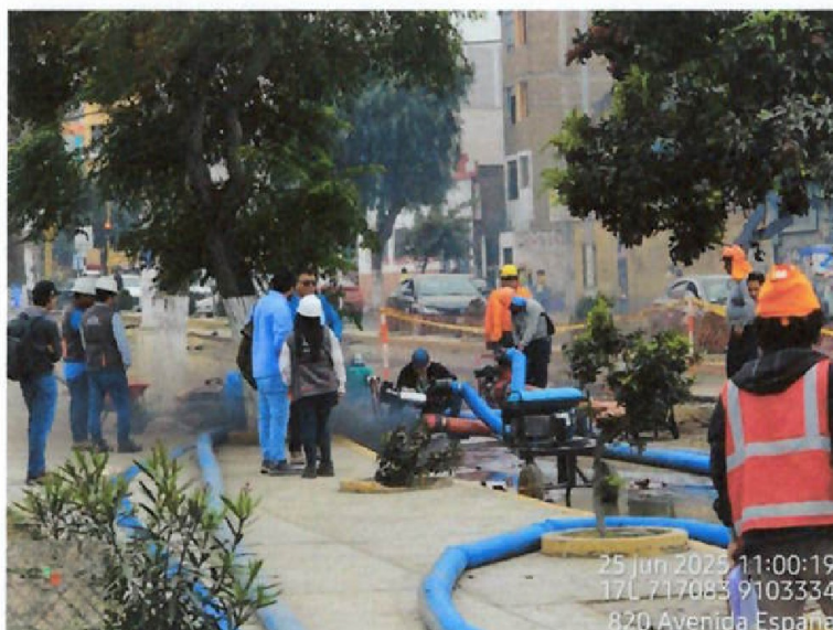
Vista fotográfica n.º 16: Emisión de humo negro proveniente de la motobomba utilizada en el frente de trabajo en la intersección de la Av. España y Jr. Gamarra
