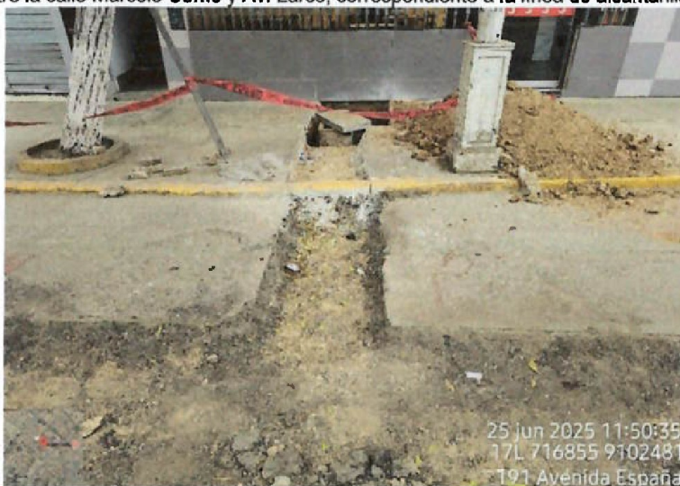
Vista fotográfica n.º 47: Trabajos de excavación para conexiones domiciliarias en la avenida España en el tramo entre la calle Marcelo Come y Av. Larco
