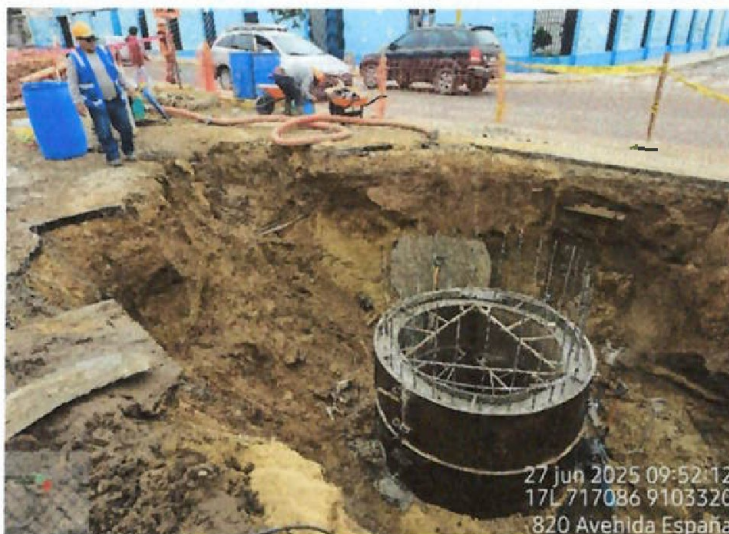
Vista fotográfica n.º 10: Zona de excavación para buzones en la Av. España con Jr Gamarra
