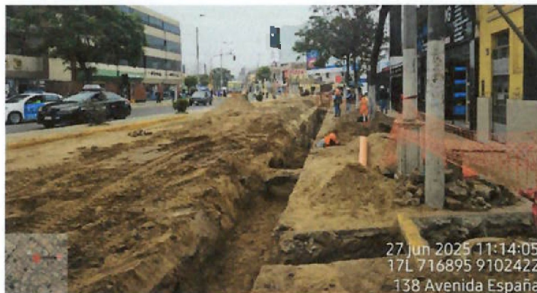
Vista fotográfica n.º 40: Excavación para línea de alcantarillado de PVC de 200 mm en la Av. España entre la calle Marcelo Corne y Av Larco
