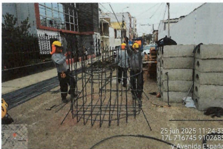
Vista fotográfica n.º 25: Personal obrero realizando trabajos de habilitación de acero en el exterior del almacén sobre la calzada de la calle Torre Tagle; además, se evidenció cajas de desagüe en el exterior del almacén.
