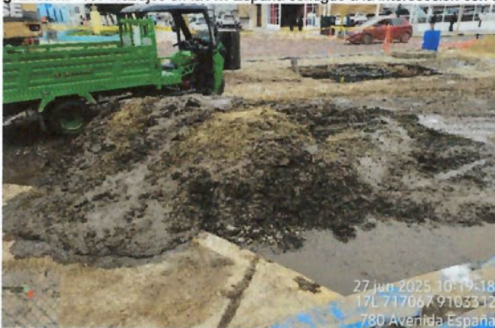
Vista fotográfica n.º 20: Material propio extraído de la zanja con presencia de aguas residuales en la Av. España contiguo a la intersección con Jr Gamarra
