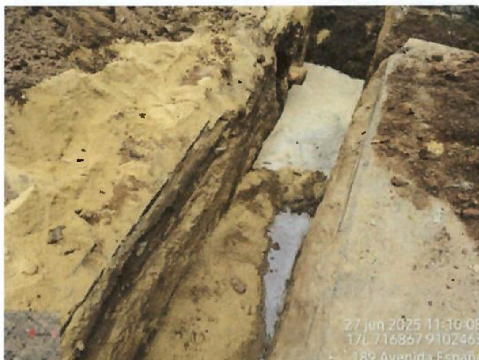
Vista fotográfica n.º 31: Presencia de aguas residuales en la zanja para la línea de alcantarillado de PVC de 200 mm en la Av. España entre la calle Marcelo Come y Av Larco
