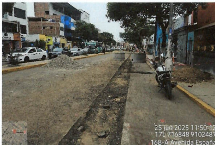
Vista fotográfica n.º 46: Corte y demolición del pavimento existente realizado en la avenida España en el tramo entre la calle Marcelo Come y Av. Larco, correspondiente a la línea de alcantarillado.
