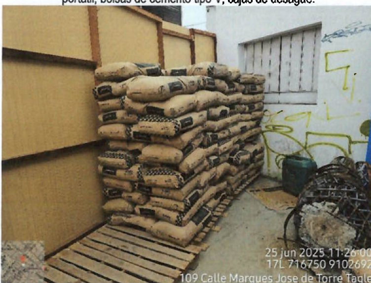
Vista fotográfica n.º 29: Interior del almacén de obra, en donde se evidencia, entre otros, bolsas de cemento tipo V.
