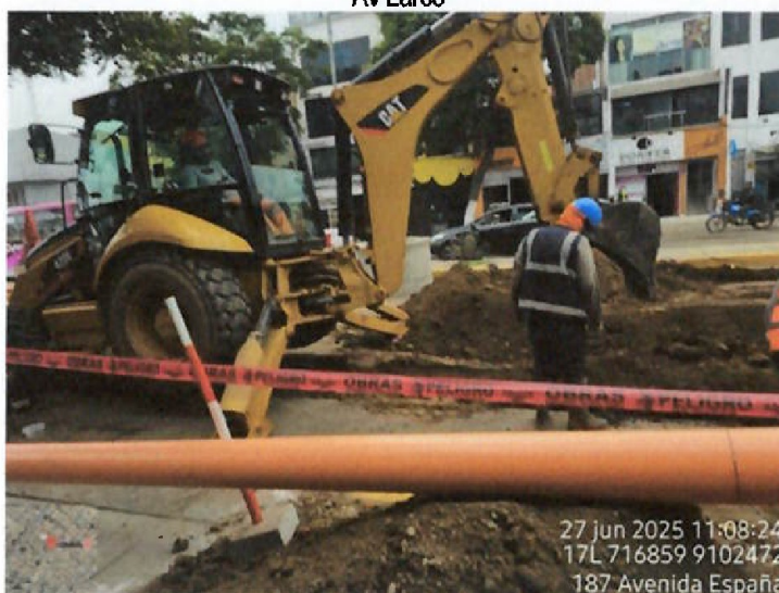
Vista fotográfica n.º 26: Excavación para línea de alcantarillado de PVC de 200 mm en la Av. España entre la calle Marcelo Corne y Av Larco
