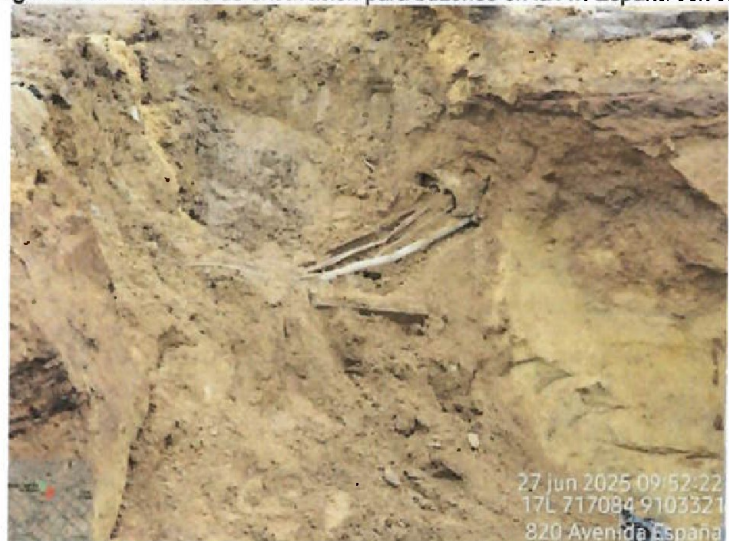
Vista fotográfica n.º 11: Presencia de redes existentes en la zona de excavación para buzones en la Av. España con Jr Gamarra
