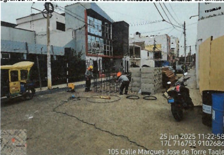
Vista fotográfica n.º 24: Personal obrero realizando trabajos de habilitación de acero en el exterior del almacén sobre la calzada de la calle Torre Tagle; además, se evidenció cajas de desagüe en el exterior del almacén.
