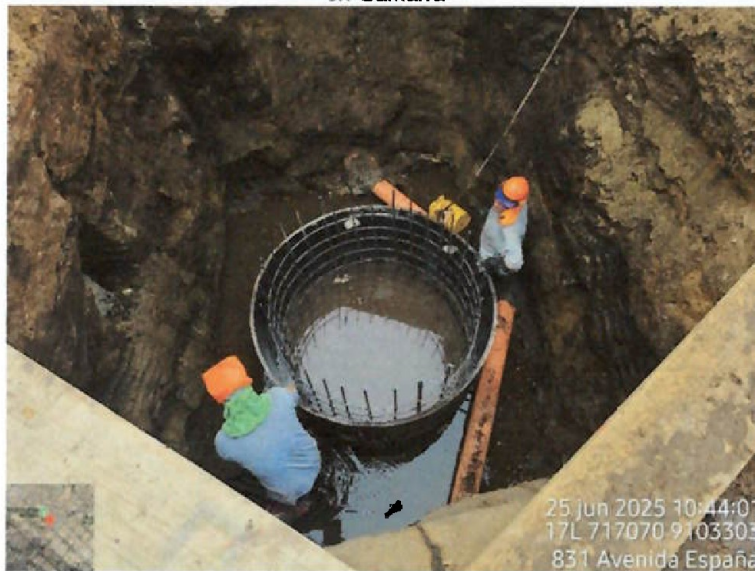
Vista fotográfica n.º 9: Presencia de aguas residuales en la zona de trabajo de la intersección de la Av. España y Jr. Gamarra
