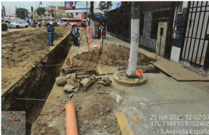
Vista fotográfica n.º 61: Trabajos de excavación para conexiones domiciliarias y red principal en avenida España en el tramo entre la calle Marcelo Corne y Av. Larco
