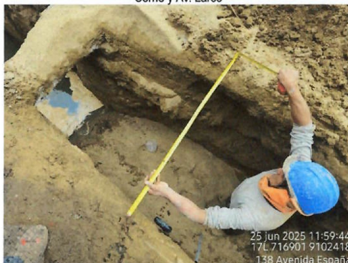
Vista fotográfica n.º 56: Ancho de zanja de 0,90 m en avenida España en el tramo entre la calle Marcelo Come y Av. Larco
