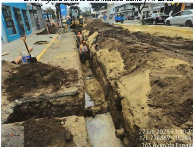
Vista fotográfica n.º 32: Presencia de aguas residuales en la zanja para la línea de alcantarillado de PVC de 200 mm en la Av. España entre la calle Marcelo Come y Av Larco
