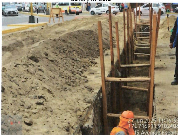
Vista fotográfica n.º 45: Tablestacado para zanja de la línea de alcantarillado de PVC de 200 mm en la Av. España entre la calle Marcelo Corne y Av Larco
