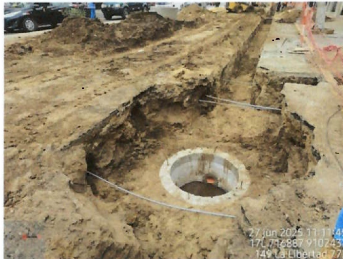
Vista fotográfica n.º 37: Fuste de buzón en la Av. España entre la calle Marcelo Corne y Av Larco
