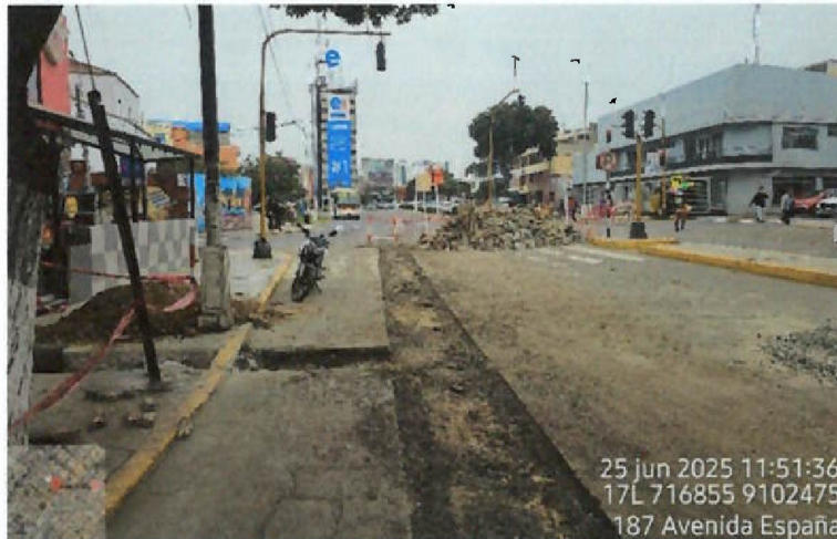
Vista fotográfica n.º 49: Corte y demolición del pavimento existente realizado en la avenida España en el tramo entre la calle Marcelo Come y Av. Larco, correspondiente a la línea de alcantarillado.
