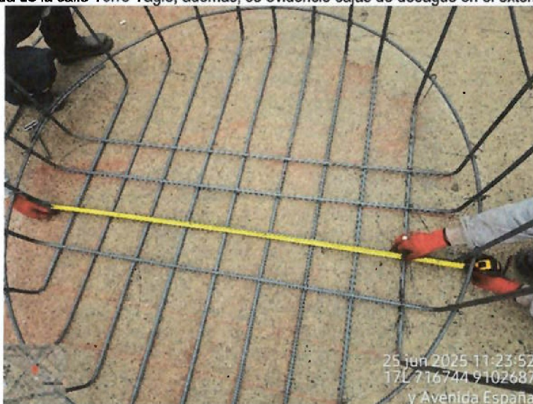
Vista fotográfica n.º 26: Armando de estructura de acero de 1/2" con un diámetro interior de 1,50 m, realizado sobre la calzada de la calle Torre Tagle
