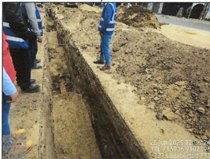
Vista fotográfica n.º 66: Zanja para red de alcantarillado en avenida España en el tramo entre la calle Marcelo Come y Av. Larco
