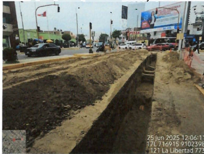
Vista fotográfica n.º 65: Zanja para red de alcantarillado en avenida España en el tramo entre la calle Marcelo Come y Av. Larco
