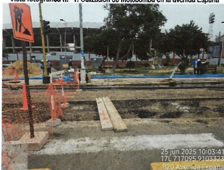
Vista fotográfica n.º 2: Corte y demolición realizado al pavimento existente, tablas instaladas para el cruce peatonal
