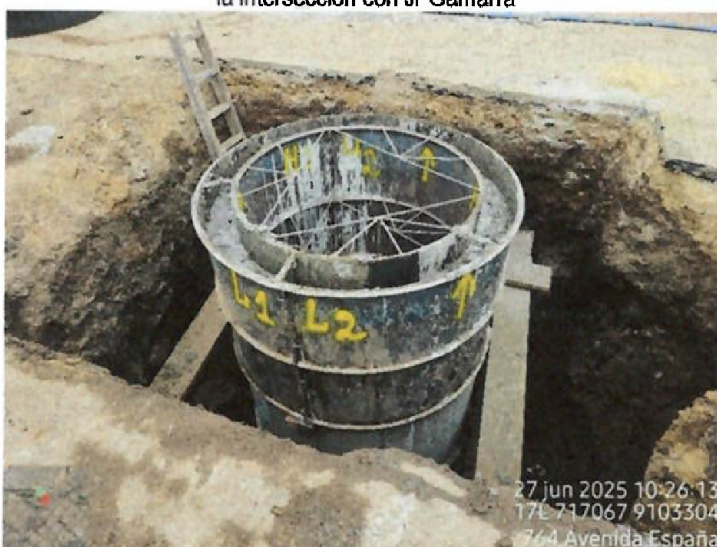
Vista fotográfica n.º 21: Concreto vaciado en buzó tipo II en la Av. España contiguo a la intersección con Jr Gamarra
