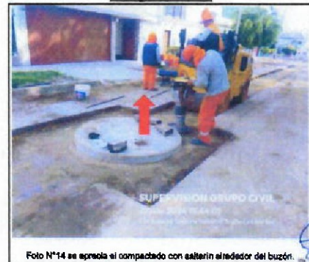
Foto N°14 se aprecia el compactado con salterín alrededor del buzón.
