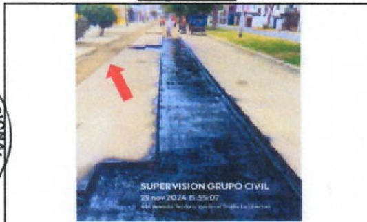
Foto N°07 otra foto en donde se aprecia la realización de la imprimación en la Av. Teodoro Valcárcel.
