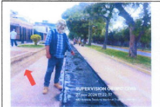
Foto N°05 Se aprecia la realización de la imprimación en la calle Teodoro Valcárcel.
