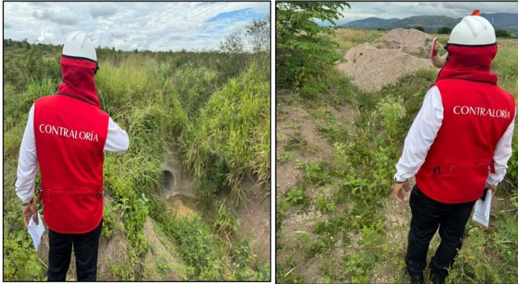
En las fotografías n.ºs 1 a la 4, se muestra parte de los canales del Sistema de drenaje existente del aeropuerto de Jaén, con presencia de abundante vegetación.
