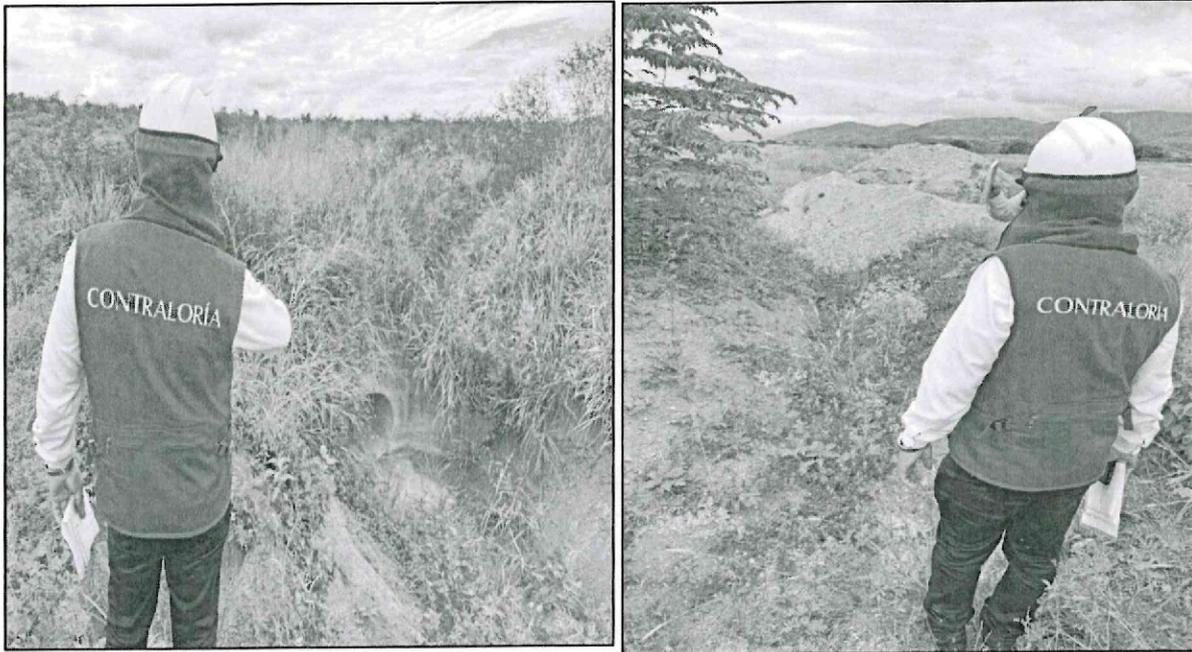
En las fotografías se muestran parte de los canales del Sistema de drenaje existente del aeropuerto de Jaén, con presencia de abundante vegetación.
