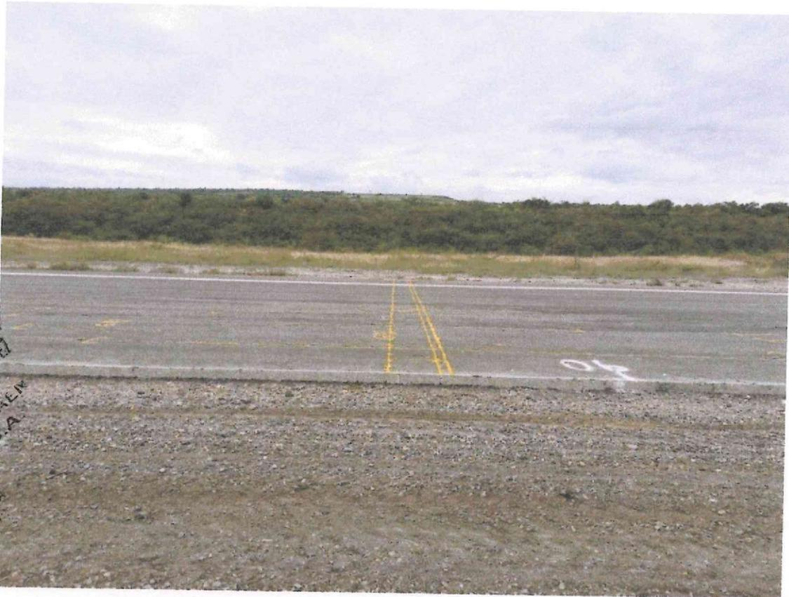
4. Zona A3, según el “Plano de reemplazo de asfalto en frío a caliente – RA-01, se advierte la ejecución de las partidas: 02.01.01 Trazo y replanteo, 02.01.02 corte de pavimento e 4”, 02.01.03 Remoción de asfalto en frío existente, 02.01.04 Eliminación de material excedente (progresiva 0 +820 al 1+100). Se visualiza a nivel de base granular, así también el trazo en el pavimento existente para la proyección de un subdrenaje transversal.
