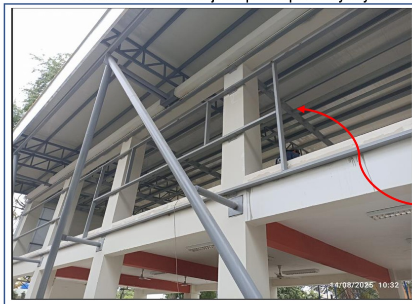
Imagen n.º 10 Pendiente culminar trabajos de placa superboard y de yeso
