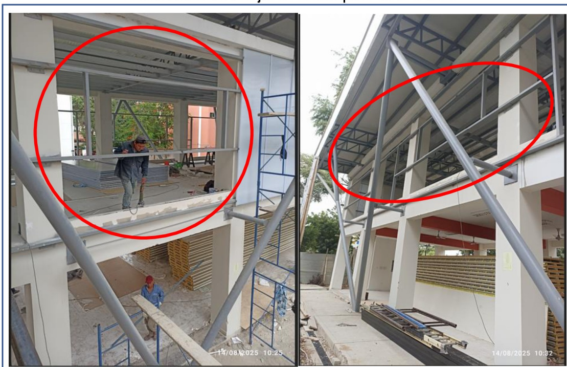
Imágenes n.º 8 y n.º 9 Pendiente culminar trabajos del Muro de panel TOPGAL 16mm
