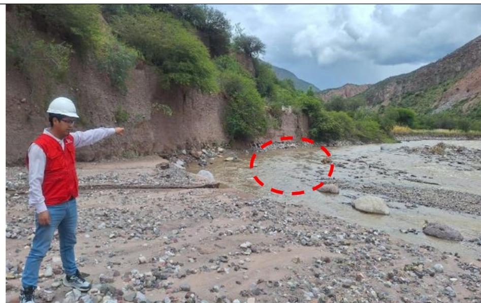
Imagen n.º 2 Captación de agua
