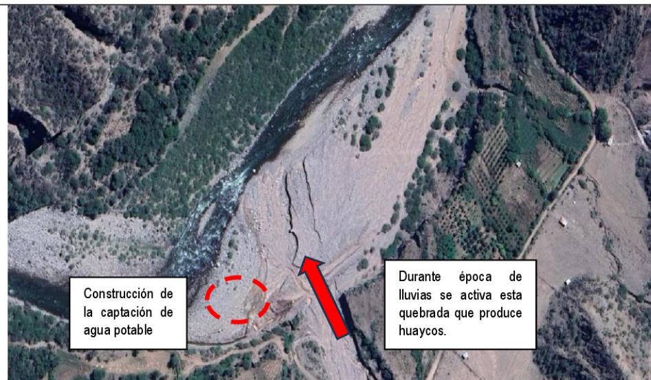
Imagen n.º 1 Captación de agua
