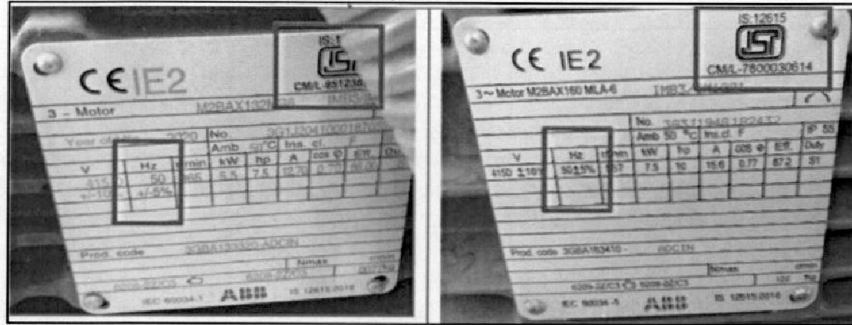
Fuente: Visita de inspección de 17 de noviembre de 2021
