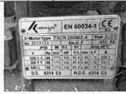
Imagen 6: Placa de datos de motor eléctricos marca Kraftmann de compresor booster de 75kW de potencia y 60Hz de frecuencia.
