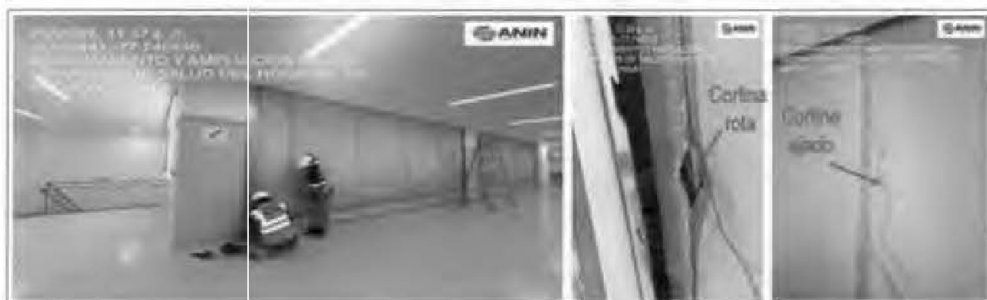
Imagen n.° 12 Cortinas cortafuego del 2do nivel
