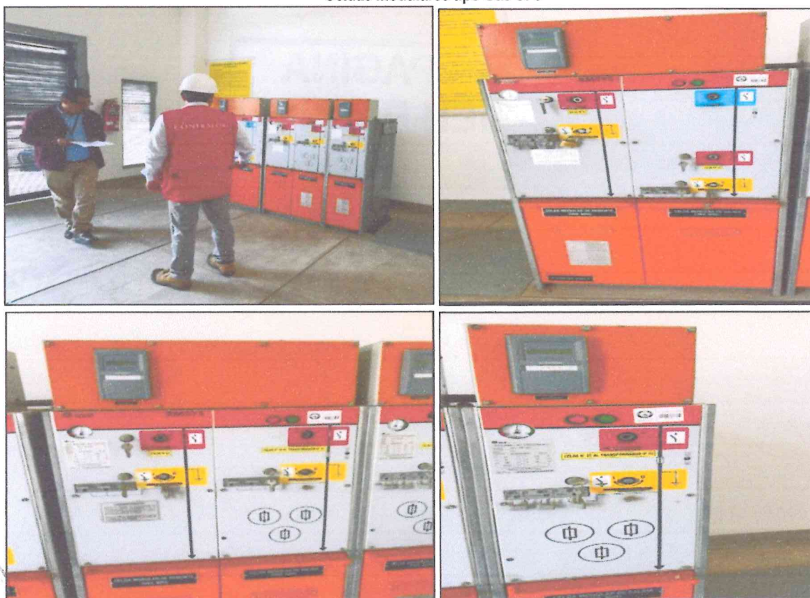
Imágenes n.ºs 16, 17, 18 y 19 Celdas modulares tipo Gas SF6
