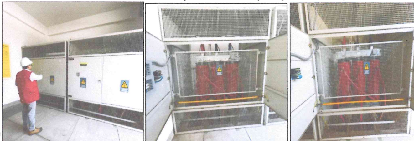
Imágenes n.ºs 13, 14 y 15 Celdas de transformación 1 y 2 - Transformadores tipo encapsulados en resina (seco)
