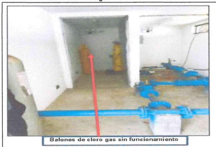
Imagen n.° 71 Balones de cloro gas sin funcionamiento
