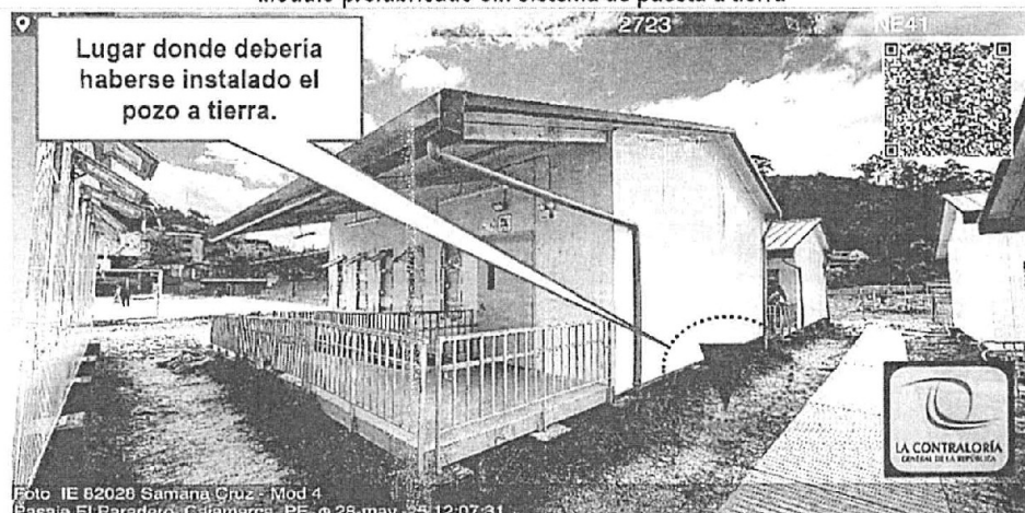
Imagen N° 23 Módulo prefabricado sin sistema de puesta a tierra
