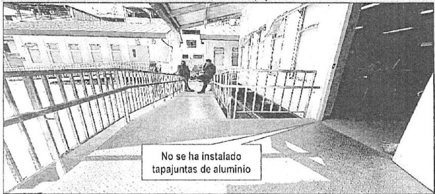
Imagen N° 22 Puerta de módulo sin tapajuntas
