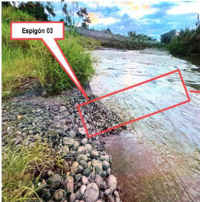
Se evidencia el espigón 03 fue afectado por socavación, resultando en su colapso por la acción del flujo del agua
