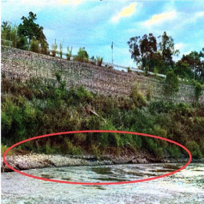
Se evidencia presencia de socavación en las estructuras de protección con gaviones, lo que indica una erosión del suelo debajo de los gaviones y posiblemente un debilitamiento de su función de protección.
