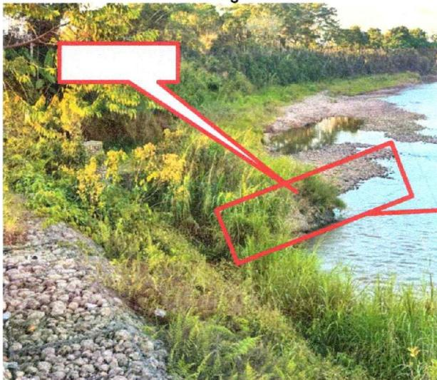
Se evidencia el espigón 06 fue afectado por la erosión fluvial, resultando en su colapso por la acción del flujo del agua
