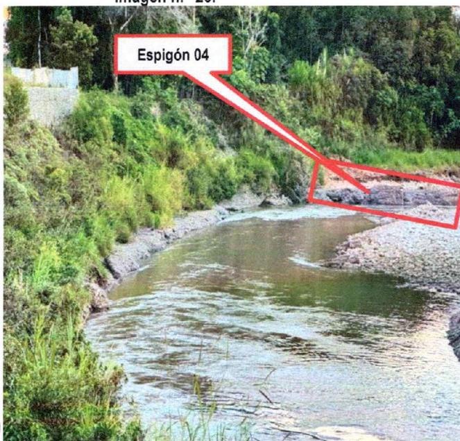
Se evidencia el espigón 04 fue afectado por la socavación, resultando en su colapso por la acción del flujo del agua
