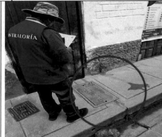
Fotografía n.º 31: Junta de dilatación de vereda que intercepta a caja de desagüe, progresiva 0+280 - jirón Leoncio Prado.
