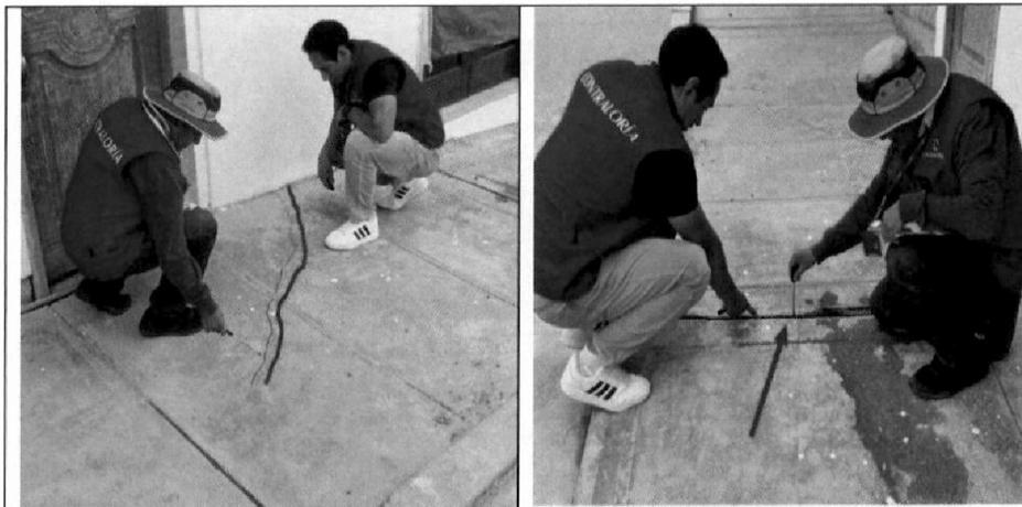
Fotografía n.° 12: Existencia de fisura en veredas en la progresiva 0+000 - jirón Leoncio Prado.
