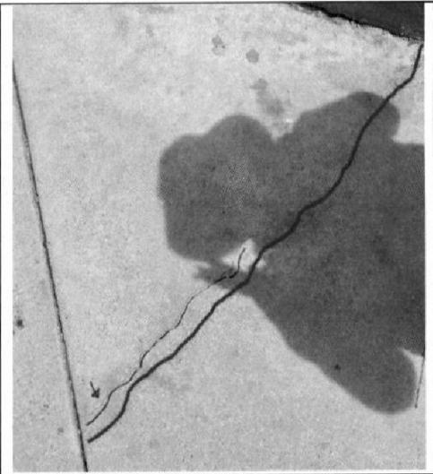
**Fotografía n.º 9:** Grieta en pavimento en la progresiva 0+145.
