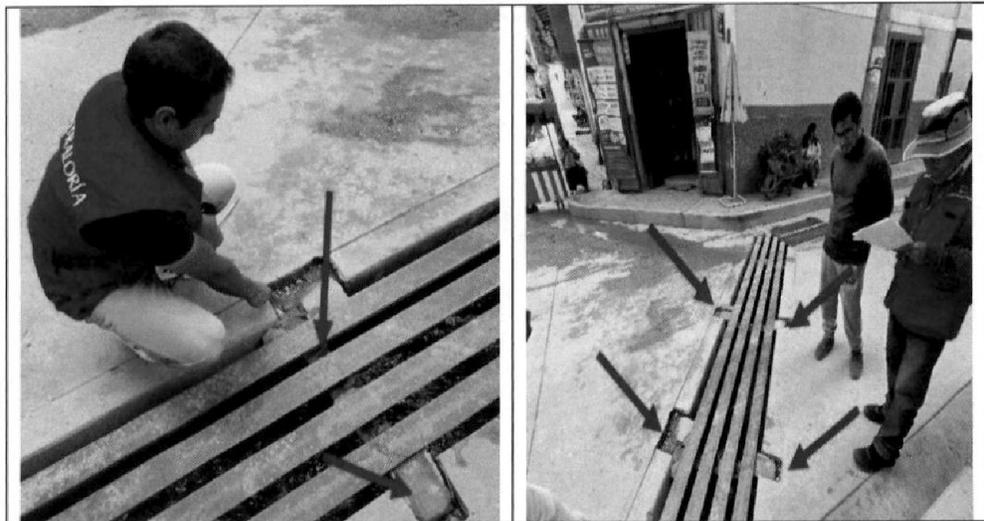
Fotografía n.° 18 y 19: Dados de fijación en rejillas deteriorados en la progresiva 0+265 - jirón Inclán.
