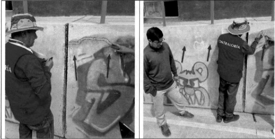
Fotografía n.° 10 y 11: Fisuras en muros de contención en la progresiva 0+560 del jirón Leoncio Prado
