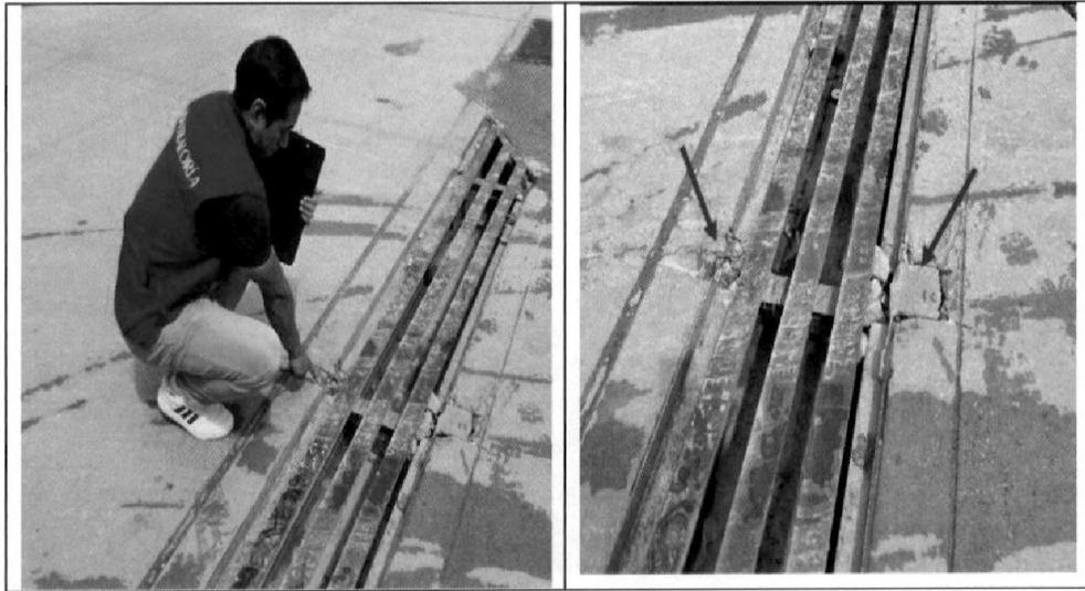
Fotografía n.º 20 y 21: Dado de anclaje deteriorado en rejilla de canal en la progresiva 0+490- jirón Inclán.
