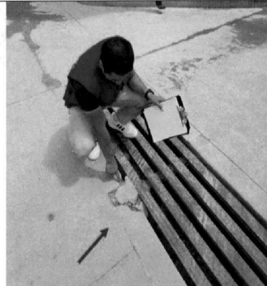
Fotografía n.º 22: Dado de concreto de anclaje de rejilla deteriorado en la progresiva 0+412 - jirón Inclán.
