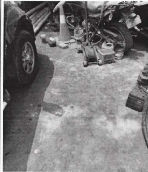
Imagen n.º 22 Piso en mal estado con presencia de piedra chancada y cemento
