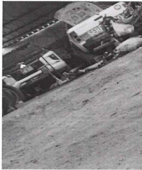
Imagen n.º 22 Piso en mal estado con presencia de piedra chancada y cemento
