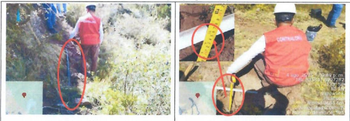
Imagen n.º 65: Vista donde se realizó la calicata n.º 3, constatándose la profundidad de entierro de la tubería de la línea de conducción de 0.00 metros = 0.00 centímetros.
