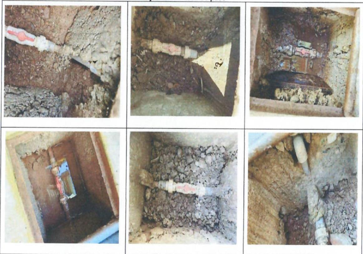
**Imagen n.º 45, 46, 47, 48, 49 y 50:** Se evidencia que, en todas las cajas de válvulas de pase de las instalaciones domiciliarias que éstas fueron construidas dentro de la vereda, poseen acumulación de lodo, base de material suelto, la caja de concreto no posee tarrajeo y presenta filtración de agua; así mismo, las referidas conexiones domiciliarias no cuentan con un marco y tapa termoplástica; así como, tampoco con una caja termoplástica que incluye solado.
