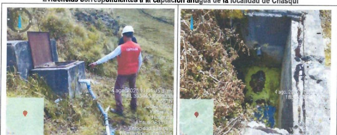
Imagen n.º 15: Vista que advierte como los pobladores ante la falta de agua, han tenido que reutilizar la captación de agua potable para consumo humano del sistema antiguo. Véase la precaria conexión de las tuberías utilizadas y su exposición a la intemperie.
