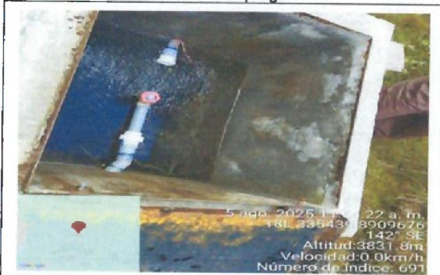
Imagen n.º 98: Se visualiza la válvula de purga que por no tener la tapa metálica su mecanismo de seguridad le ha sustraído un niple por lo que ya no puede purgar al exterior. De igual manera, la tapa metálica solo cuenta con pintura anticorrosiva, no cuenta con pintura esmalte, motivo por el cual se encuentran oxidadas. Lo mismo en todas las tapas de la captación, válvula de aire, válvula de purga y caja de distribución de caudales. No existe cámara rompe presión tipo VI.
