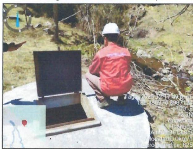
**Imagen n.º 35:** Se verificó que el biodigestor, caja de lodos y pozo percolador poseen tapas metálicas que solo cuentan con pintura anticorrosiva, no cuentan con pintura esmalte, motivo por el cual se encuentran oxidadas. De igual manera, carecen del mecanismo de seguridad.
