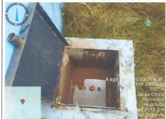
**Imagen n.º 4:** Vista donde se visualiza la caja de válvula de control con agua, lo que indica fuga de agua en la captación y el motivo por el cual la válvula de control se encuentre malograda. Así mismo, la tapa metálica de la caja de válvula de control de la captación carece del mecanismo de seguridad. Así también, se evidenció que las tapas metálicas de la captación solo cuentan con pintura anticorrosiva, no cuenta con pintura esmalte, motivo por el cual se encuentran oxidadas.
