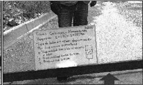
**Comentario:** Pavimento bicapa con presencia de deformación estructural entre las progresivas 1+040 km. y 1+060 km.
