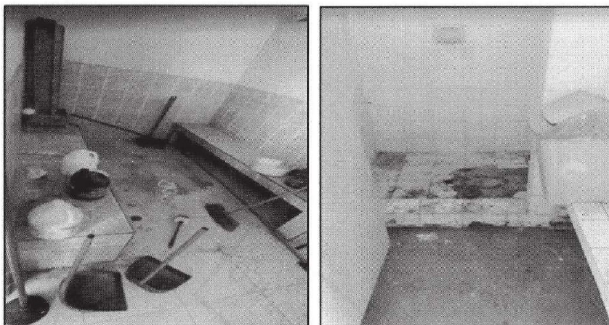
Fuente: Acta de inspección física N°. 02-2025-DREI-OCI-AC de 2 de octubre de 2025
