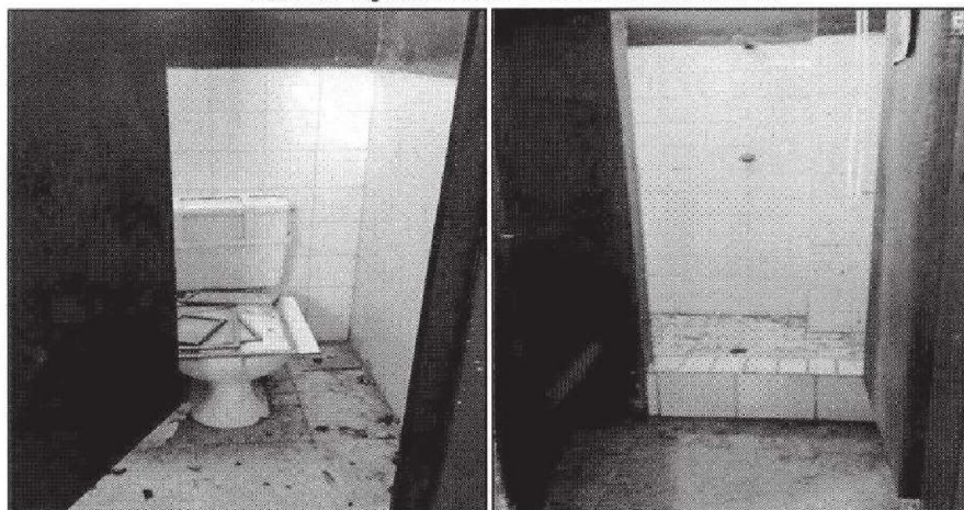
Fuente: Acta de inspección física N°. 01-2025-DREI-OCI-AC de 1 de octubre de 2025
