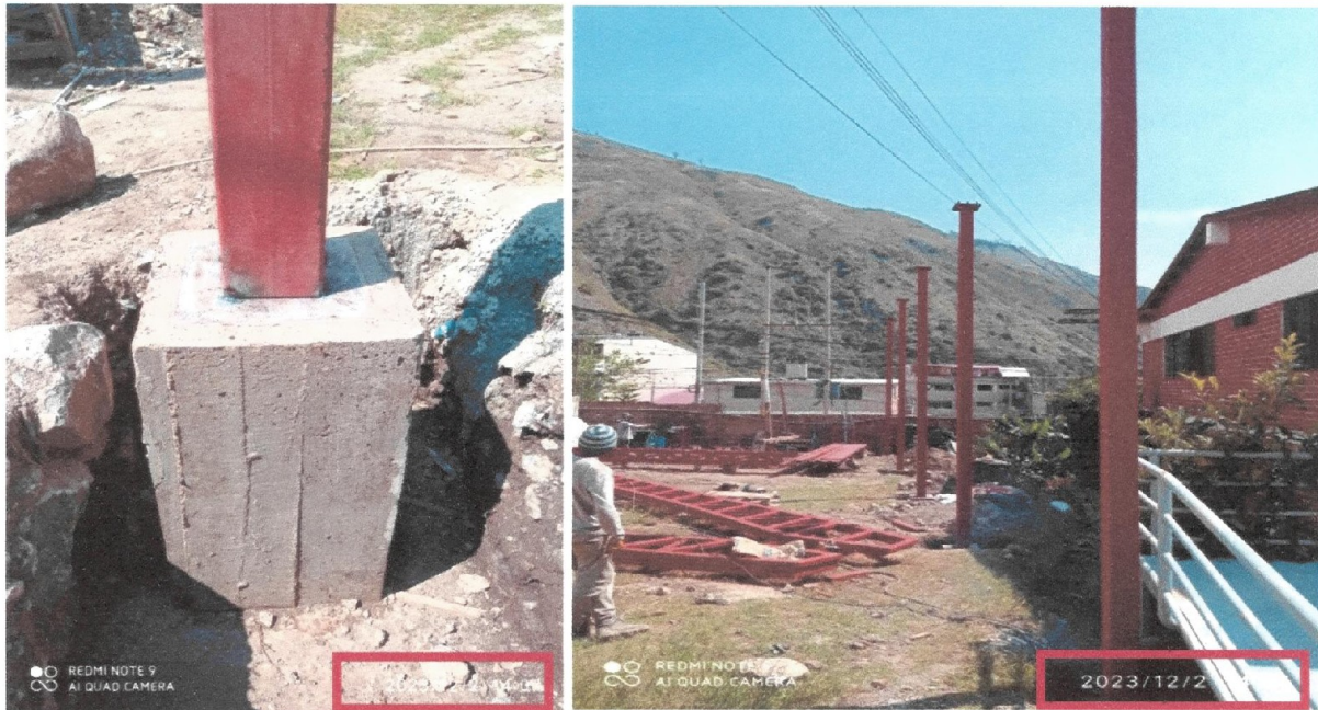
Imágenes n.ºs 6 y 7 Panel fotográfico en los que se muestran las fechas de ejecución (2023/12/2)
