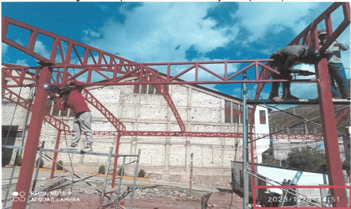
Imagen n.º 11 Panel fotográfico en el que se muestra las fechas de ejecución (2023/12/8)
