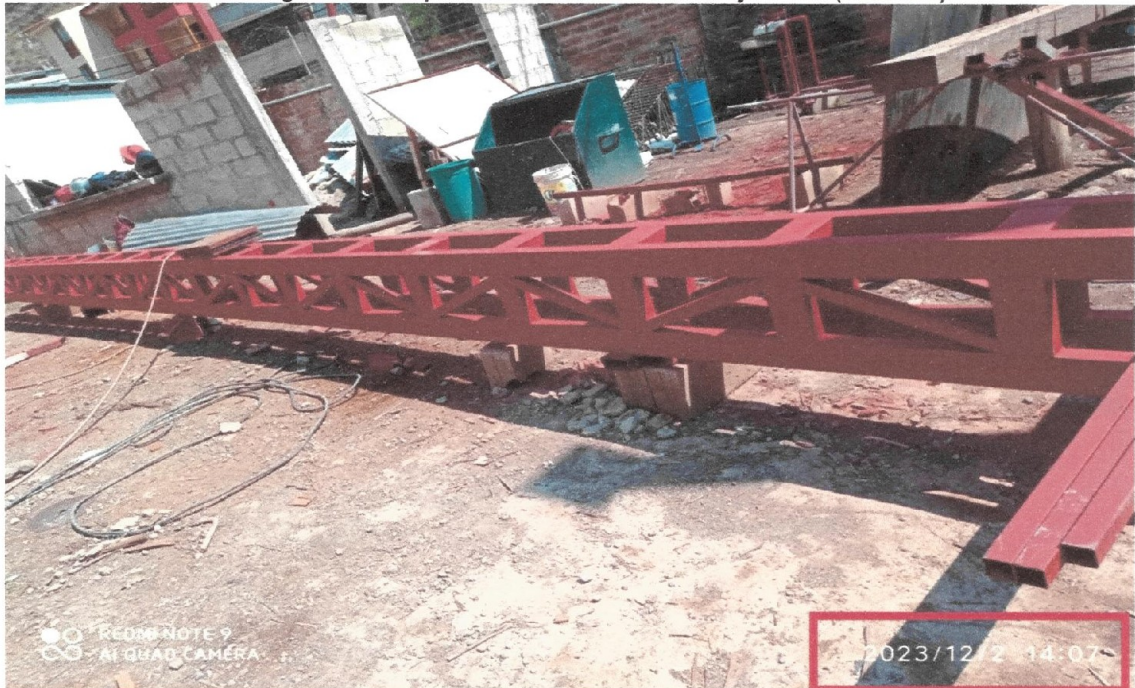
Imagen n.º 10 Panel fotográfico en el que se muestra las fechas de ejecución (2023/12/2)
