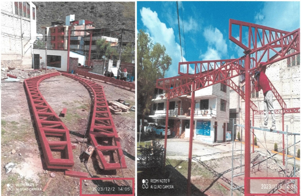
Imágenes n.ºs 8 y 9 Panel fotográfico en los que se muestran las fechas de ejecución (2023/12/2 y 2023/12/8)
