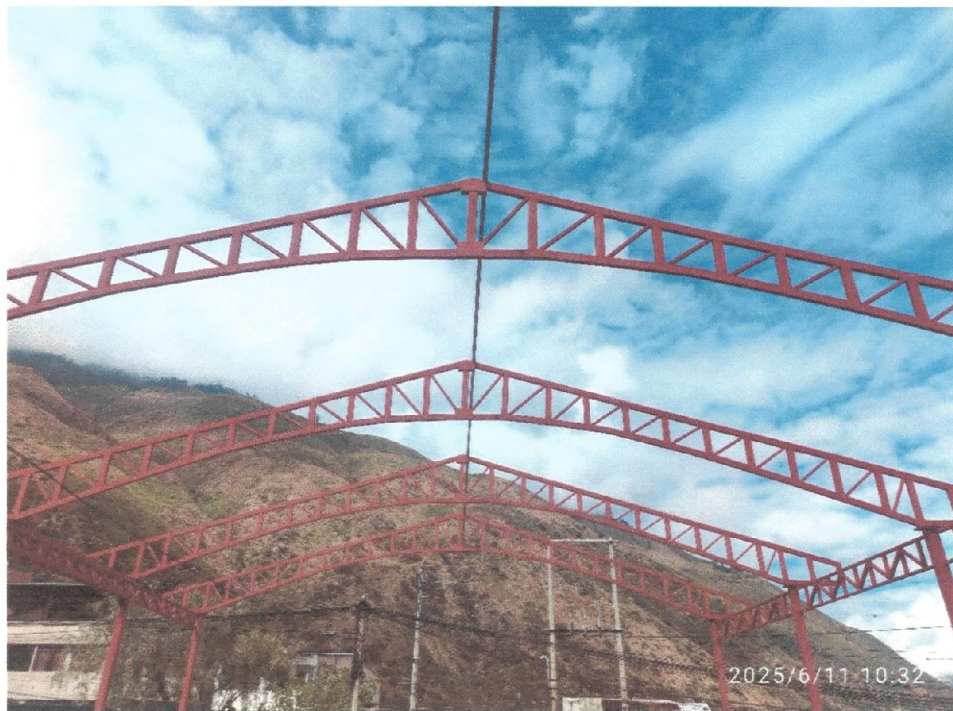
Imagen n.º 29 Avance de la partida 02.04.05. Correas metálicas de 40x60x2mm en techo
