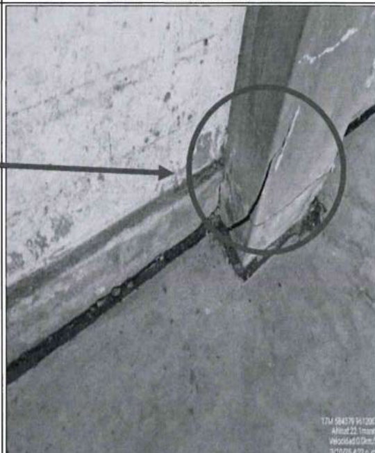
Foto N° 4: Columnas con fisuras y grietas Estación de Bombeo Pocitos Visita de Comisión Auditora
