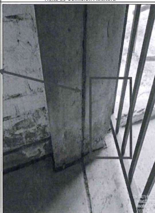
Foto N° 4: Columnas con fisuras y grietas Estación de Bombeo Pocitos Visita de Comisión Auditora
