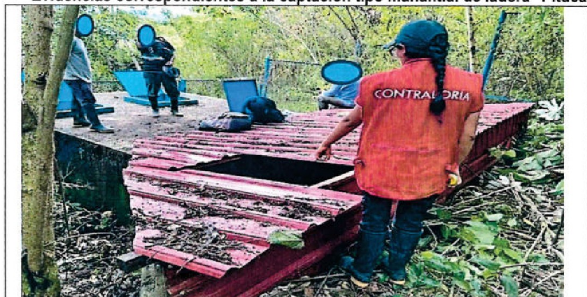
Imagen n.º 23: Se aprecia la instalación de planchas de Aluzinc para cubrir la zona del manantial, estando propensa a contaminación del medio ambiente; esta cobertura no es la señalada en los planos de expediente técnico.
