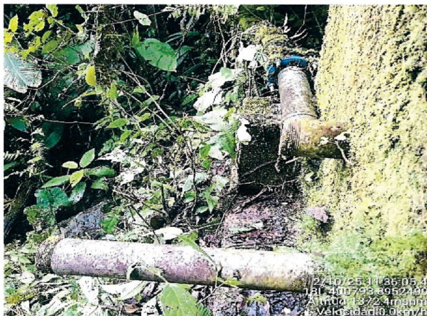
Imagen n.° 21: Las tuberías de salida de limpia y de rebose no tienen las longitudes establecidas en los planos, por lo que vienen causando erosión en el talud inferior. La caja de válvulas presenta humedad y moho.
