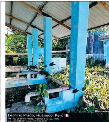
Imagen n.° 12: Las aguas residuales han provocado aniego de toda la zona transitable de la PTAR Inti, que viene afectando las componentes como Lecho de secado.
