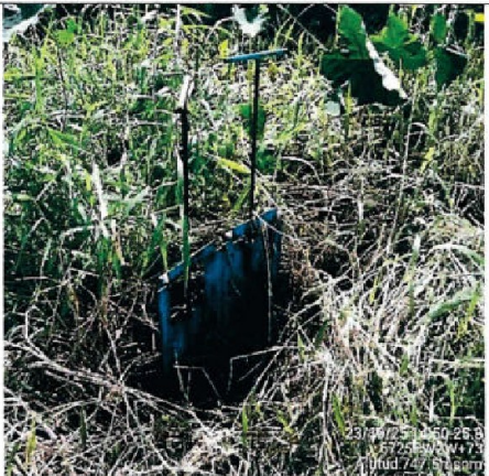
Imagen n.° 11: La cámara de rejillas y desarenador se encuentran colmatados y embebidos por el material orgánico y aguas residuales.
