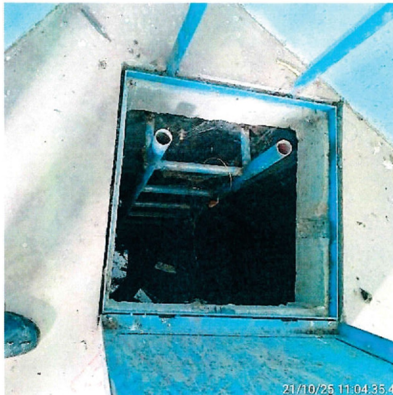
Imagen n.º 65: Escalera para mantenimiento de pozos de bombeo, se encuentran con aguas servidas hasta cierto nivel.
