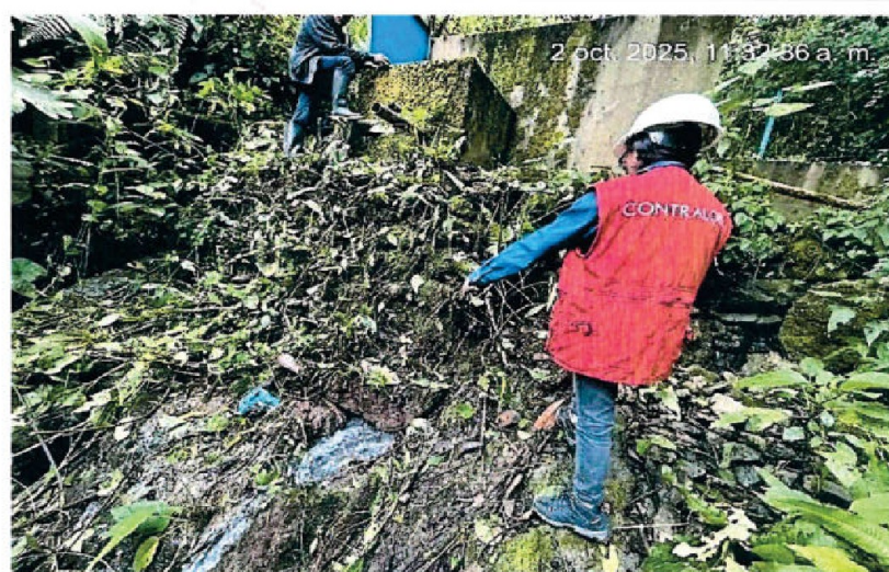
Imagen n.º 17: Se observa filtración de agua por debajo del asentado de piedra, armado para construir la captación; existe riesgo de erosión y afectación de la estructura.
