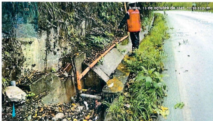
Imagen n.° 75: Se aprecia tubería PVC de desagüe conducida a través de la alcantarilla existente.
