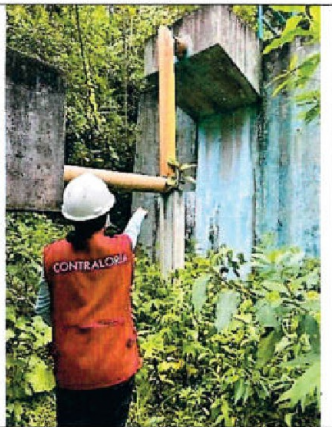
Imagen n.° 5: Filtraciones en empalme a filtro biológico.
