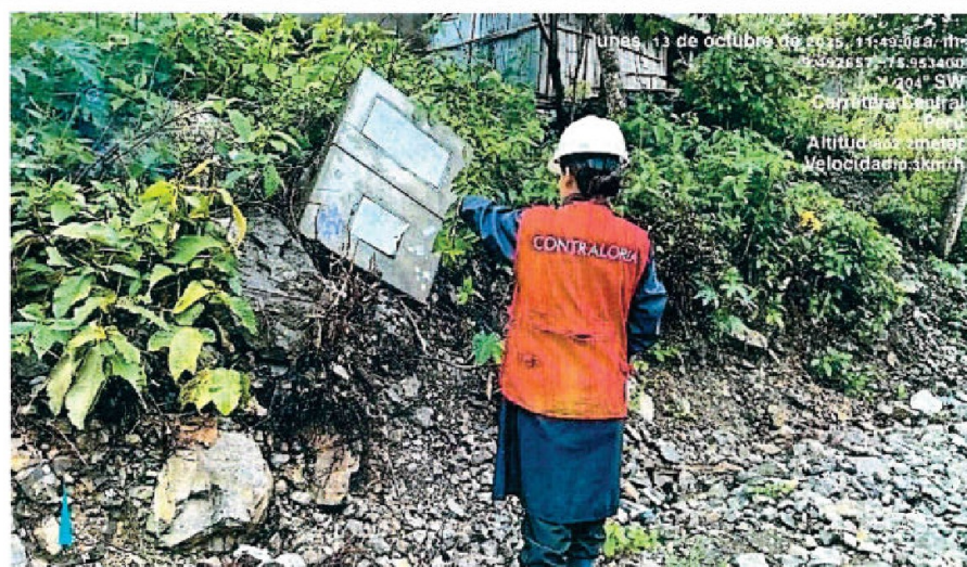
Imagen n.° 52: Se observa el colapso de las cajas de agua y registro de desagüe pre fabricadas, esto debido a que no fueron instaladas de acuerdo a lo señalado en las especificaciones en un terreno estable y/o relleno, apisonado adecuado, asimismo se evidencia que no existe una conexión con la red principal.
