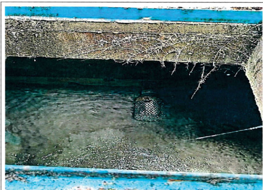
Imagen n.° 19: Se observa el nivel de agua al ras de la parte superior de la canastilla, no presenta tubería de rebose, se aprecia un orificio en el muro para la limpieza, todas ellas cuentan con una llave de válvula de bronce, la cual no corresponde a las especificaciones técnicas.
