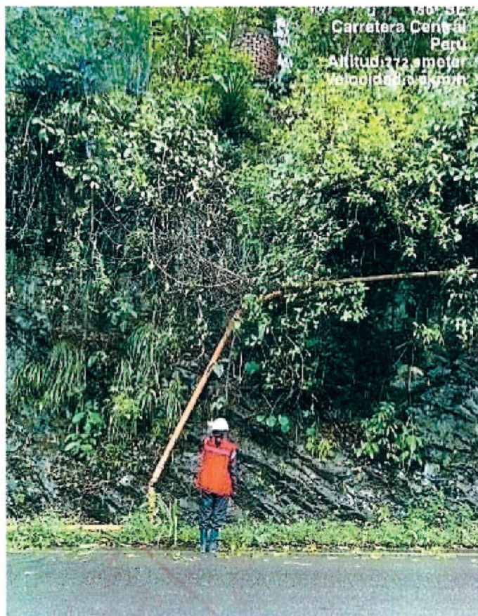
Imagen n.° 74: Se verifica que la tubería de desagüe cruza la vía nacional a través de una alcantarilla.
