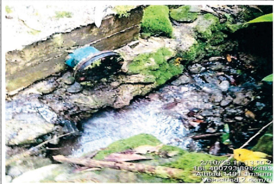
Imagen n.° 18: Se observa una válvula de compuerta de limpia en la parte lateral derecha de la cámara húmeda, la misma que no se encuentra considerada en los planos del expediente técnico y tampoco en los de liquidación; se puede observar una fuga de agua en su parte inferior.
