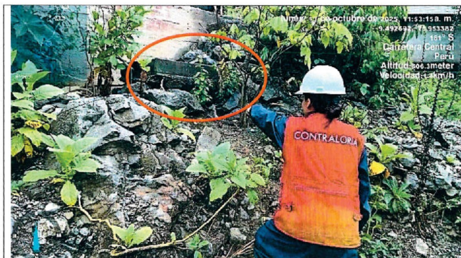
Imagen n.º 53: Se evidencia la colocación superficial de las cajas de agua y desagüe en el terreno, por lo que la ejecución de la misma no cumple con lo establecido en las especificaciones técnicas.
