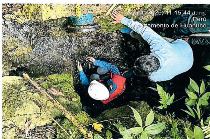
Imagen n.º 16: Se aprecia la fuga de agua en la parte inferior de la cámara húmeda (grande) o de reunión en grandes proporciones, las que vienen causando socavación en la cimentación de la estructura existente.
