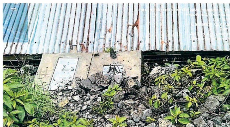
Imagen n.° 51: Las cajas de las conexiones domiciliarias se encuentran por encima del nivel de las viviendas y en zona propensas a erosionarse por el pronunciamiento del talud.
