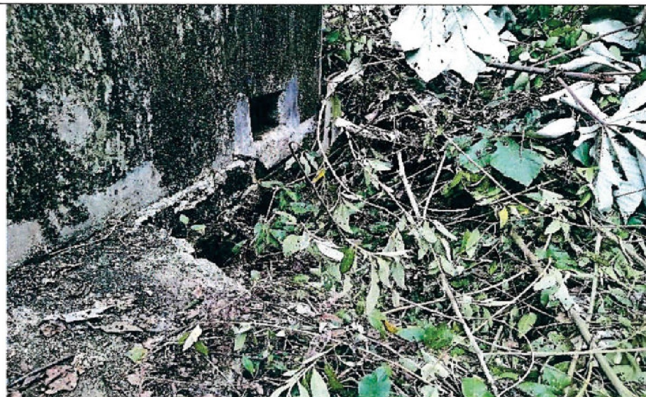
Imagen n.º 27: Se observa el colapso del canal de salida del reboso.
