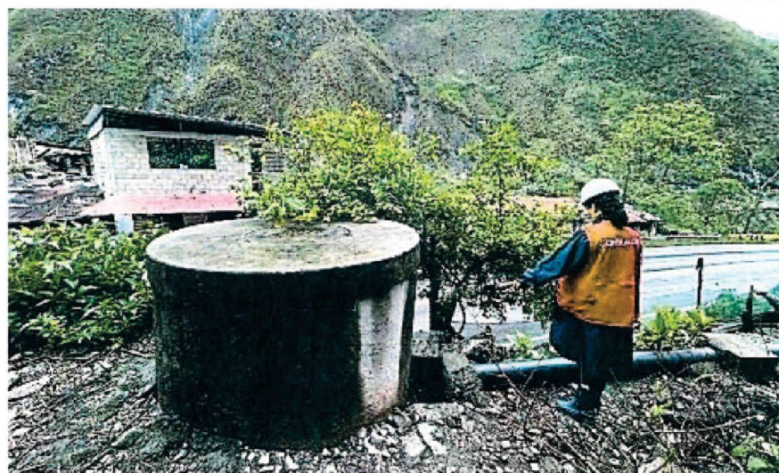
Imagen n.º 54: Se observa filtraciones en el cuerpo o muro del buzón, se siente olor y humedad, cuya tubería de ingresa es de HDPE, sujeta a dados de concreto.
