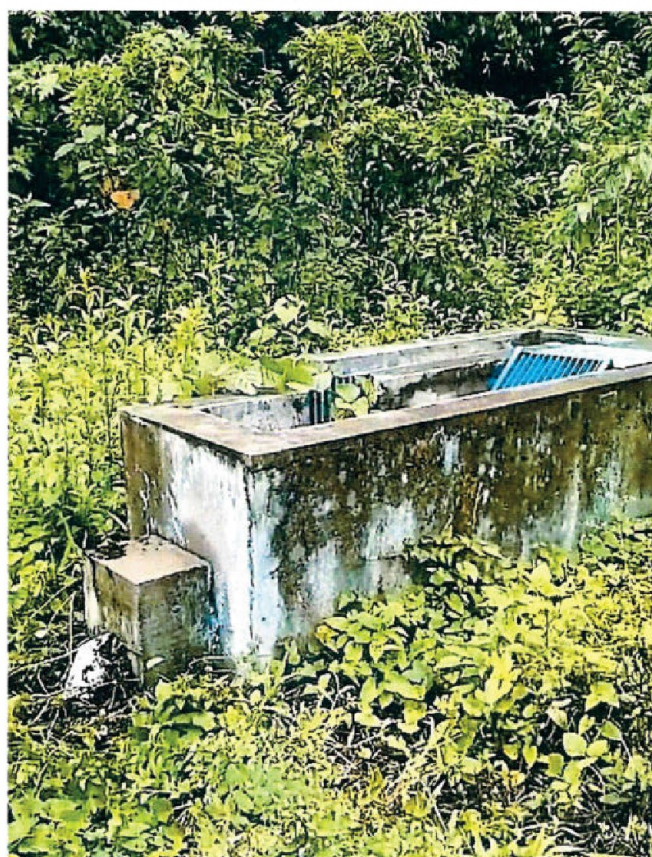
Imagen n.º 62: Cámara de rejillas.
