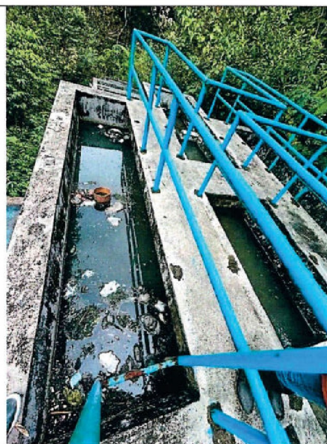
Imagen n.º 7: Se observa material como bolsas y pañales en el tanque Imhoff, debido a que no existe un operador del sistema que realice la limpieza.
