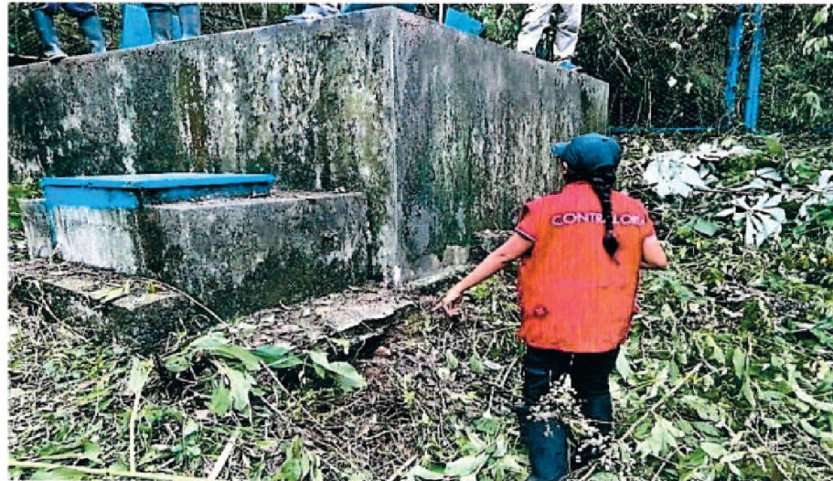
Imagen n.º 26: Se aprecia erosión y asentamiento en la parte frontal de la captación, bajo la cámara seca o de válvulas. Además, se aprecia una infraestructura con moho y sin pintura de protección.
