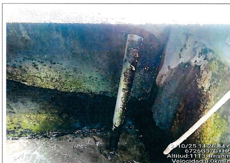
Imagen n.° 35: Tubería sin cono de rebose, se aprecia el interior con moho y tubería sucia.
