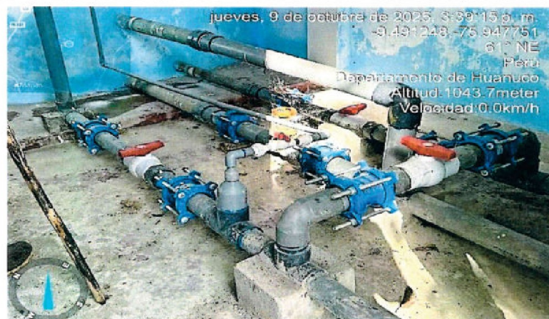
Imagen n.° 43: Cuarto de válvulas con presencia de humedad por filtraciones en la salida de tubería del reservorio.
