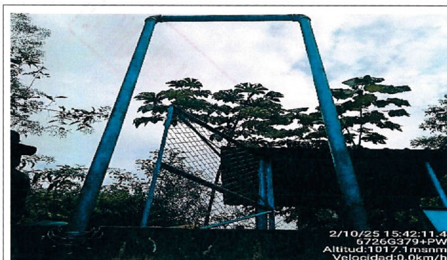
Imagen n.º 40: Se aprecia tuberías rompe presión de fierro galvanizado instalado sobre la caja de válvulas.
