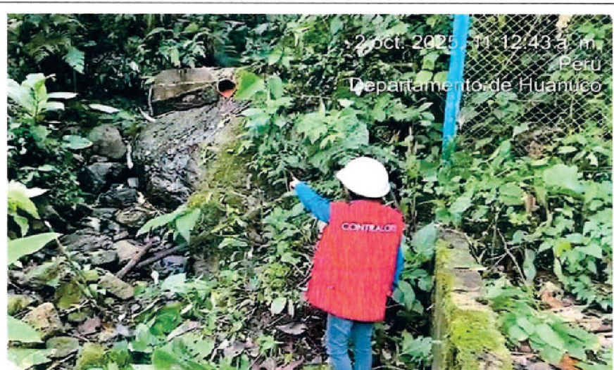
Imagen n.° 15: La estructura de la captación fue realizada en parte de una quebrada, donde se puede apreciar aguas superficiales en la zona superior y lateral de la estructura que vienen causando socavación en la parte baja, las mismas que se pueden ver afectadas en mayor magnitud en épocas de lluvias.
