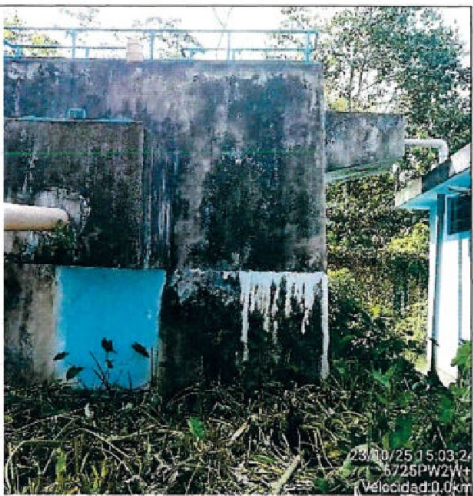
Imagen n.° 13: Se observa el filtro biológico con vegetación en su superficie, debido a que la PTAR no se encuentra en operación y la falta de mantenimiento.
