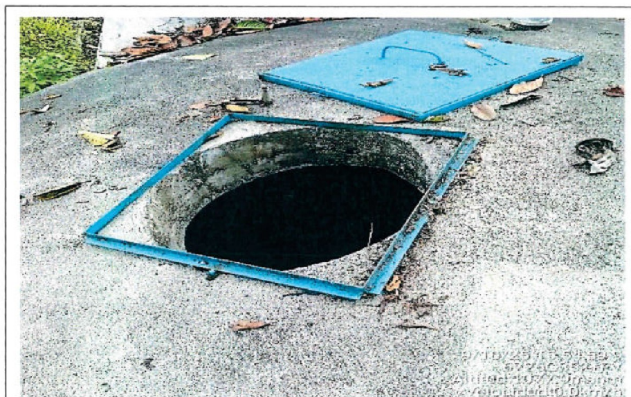
Imagen n.° 46: Ingreso al reservorio, no presenta bordes para la colocación de tapa metálica, no tiene un radio de 0.30 m por ambos lados, se visualiza ingreso de aguas de lluvia debido a que no cuenta con un sello adecuado.
