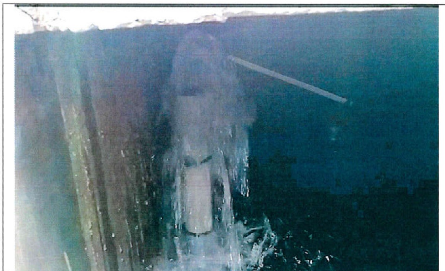
Imagen n.º 39: Se aprecia el ingreso de agua por el cono de rebose, esto debido a la alta presión de llegada al reservorio. Se aprecia acabado de tarrajeo deficiente.
