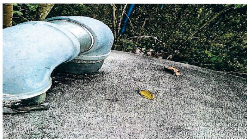
Imagen N° 45: Tubería de ventilación, mal ubicado, no cuenta con espacio suficiente para la ventilación. No está de acuerdo a los planos.
