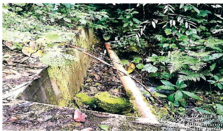
Imagen n.° 14: Tubo de PVC de desagüe conectado a la salida de un afloramiento de agua en contra pendiente. Los muros de la captación tienen presencia de moho y humedad; no se aprecia pintura en la estructura
