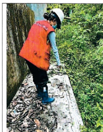
Imagen n.º 8: Presencia de fisuras en la vereda perimetral del filtro biológico.
