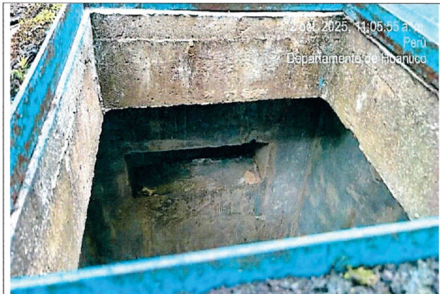
Imagen n.° 20: Se aprecia ventana para rebose de la cámara húmeda o reunión a la cámara seca para rebose, así como deficiente acabado de tarrajeo y tapa metálica con presencia de óxido.
