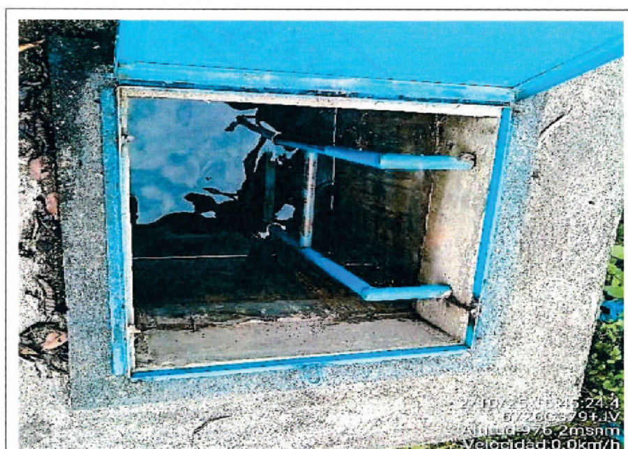
Imagen n.° 38: Se observa la instalación de escalera metálica al interior del reservorio, ocasionando contaminación del agua almacenada, se observa oxidación de marco de tapa metálica
