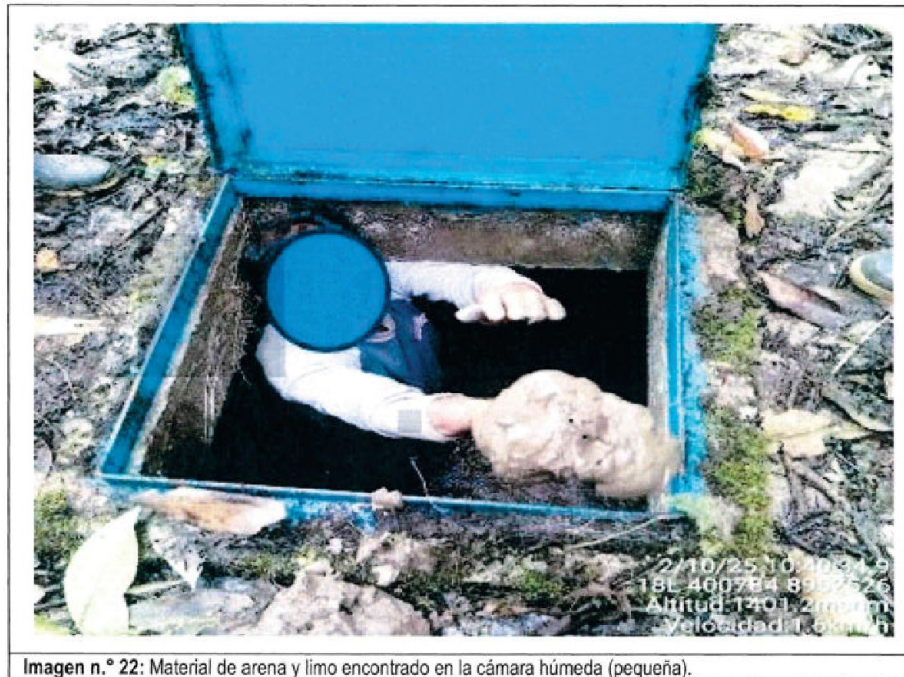
Imagen n.º 22: Material de arena y limo encontrado en la cámara húmeda (pequeña).
