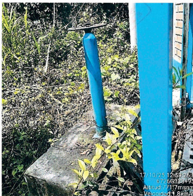
Imagen n.° 60: Compuerta de la cámara de bombeo.
