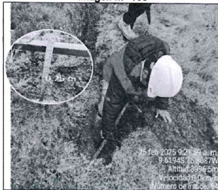
Fotografía n.° 15.- Vista que muestra la excavación en la línea de conducción en la calicata n.° 1 o punto de inspección número n.° 1, evidenciándose una profundidad de 0.25 m
