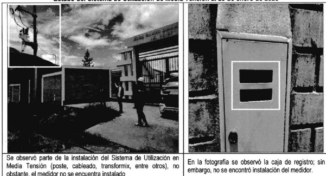
Se observó parte de la instalación del Sistema de Utilización en Media Tensión (poste, cableado, transformix, entre otros), no obstante, el medidor no se encuentra instalado
