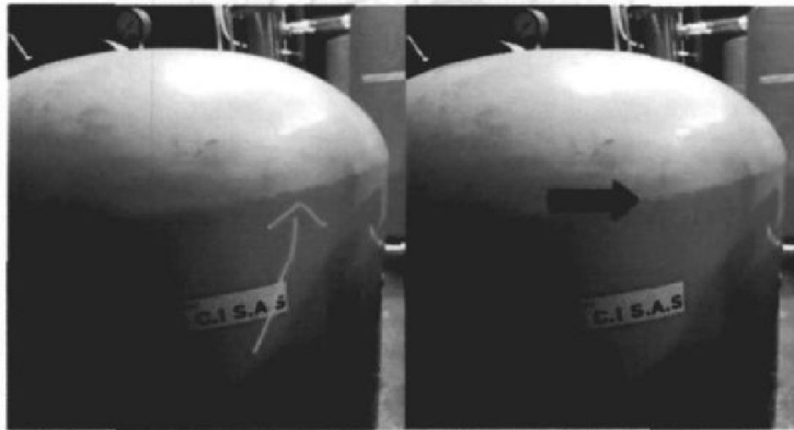
Filtros de arena y carbón con presencia de grietas / fisuras por donde pasa el agua por la presión del sistema.
