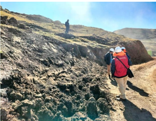
Imagen n.º 3. Cantera 4. Culluchaca, material con bolonerías de rocas y presenta zona de bofedales, por lo que cumpliría con la calidad de material requerida.
