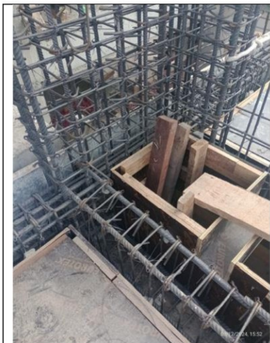
Imagen n.º 17 Vista del acero colocado para VS-200 sección 7-7
