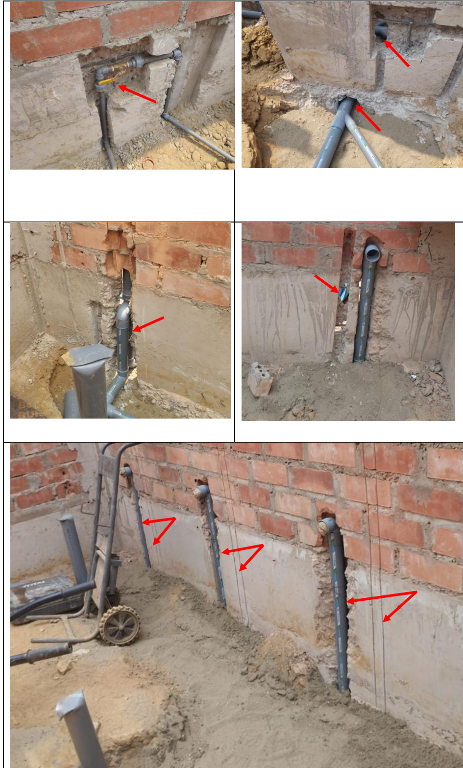
Imagen n.° 14 Cortes de elementos estructurales en SSHH
