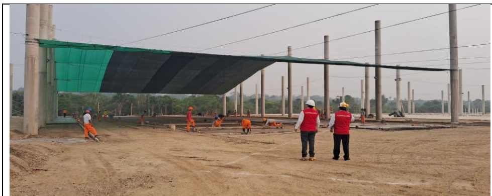
Imagen n.º 28 Instalación de cobertura con malla raschel y cable metálico
