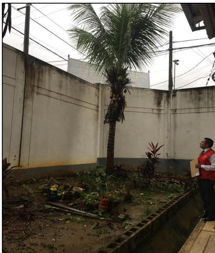
Imagen n.º 1 Cerco perimétrico - IE
