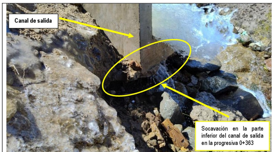
Imagen n.º 8. Socavación en el canal de salida en la progresiva 0+363.
