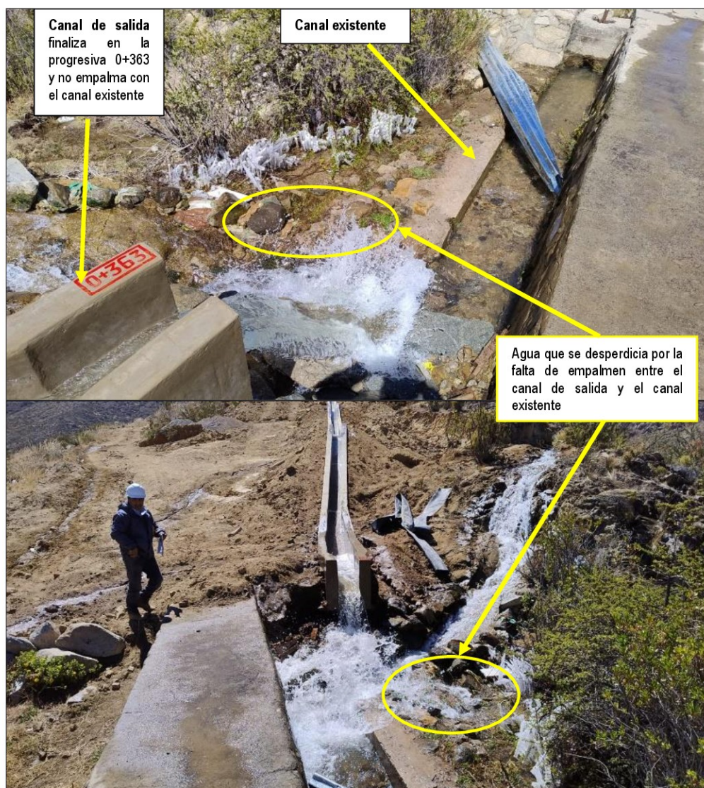
Imagen n.º 7. El agua desemboca fuera del canal existente.
