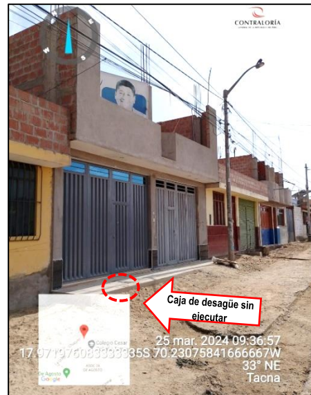
Imagen n.°14 Predio ubicado en la Mz. C Lt. 22
