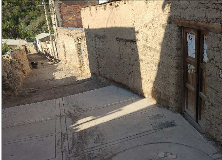
Imágenes n.º10 y 11. Tramo de calle Albarracín entre las progresivas 0+070 a 0+093
