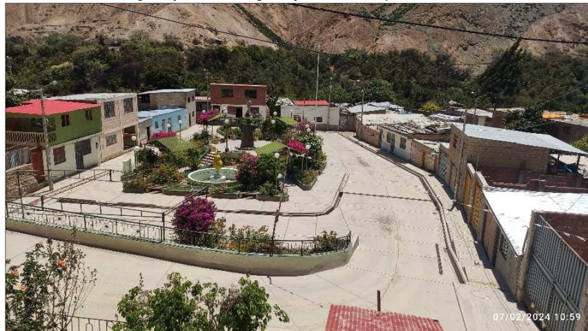
Imágenes n.º 15 y 16. Pavimento rígido ejecutado al ingreso y alrededor de plaza del Centro Poblado.
