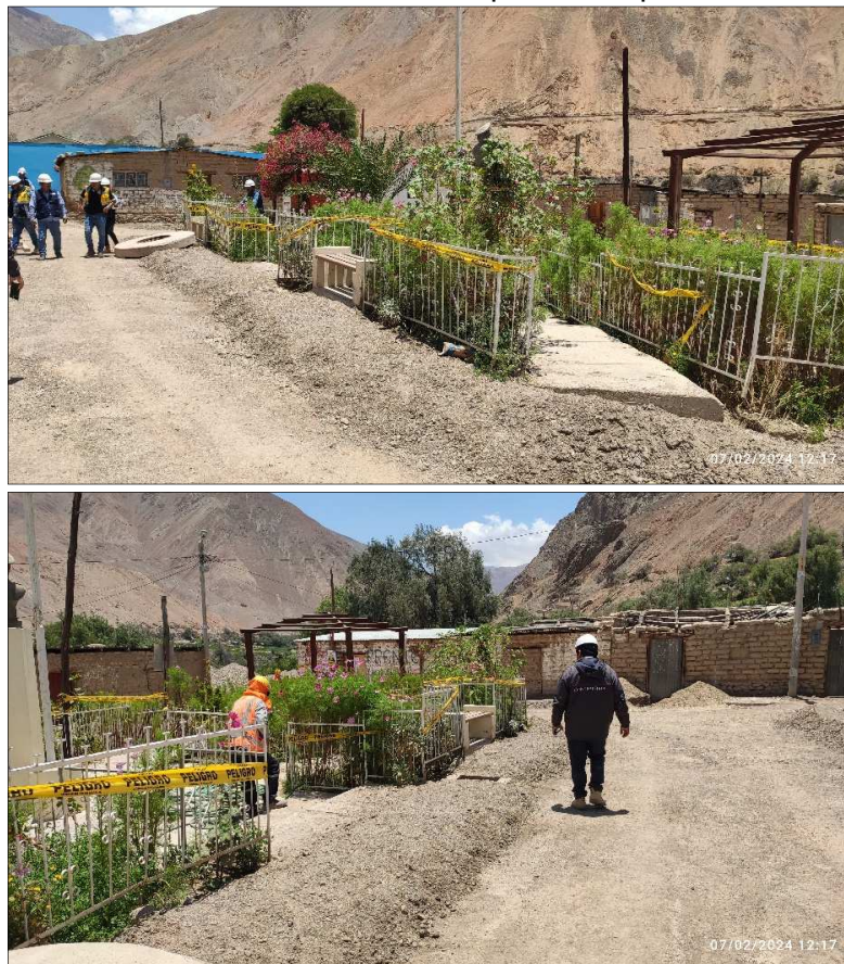
Imágenes n.º12 y 13 veredas a nivel de sub base en el perímetro de la plaza.
