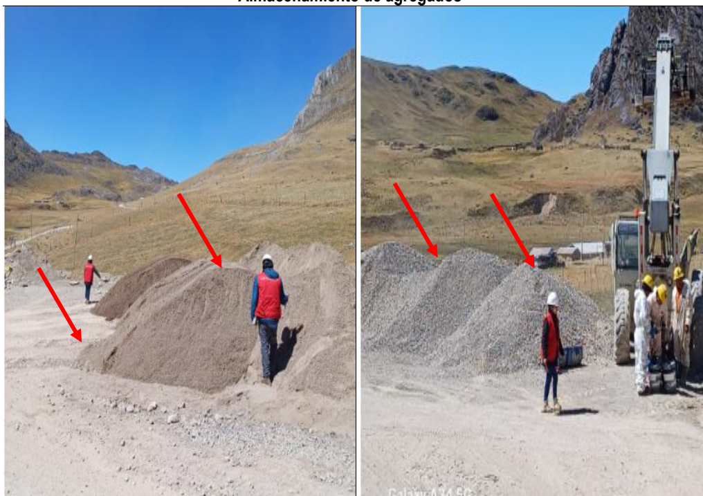
Panel Fotográfico n.º 5 Almacenamiento de agregados
