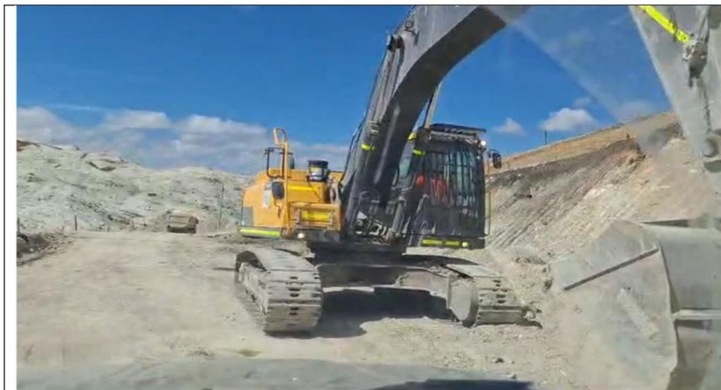
En la imagen se observa que se viene realizando corte de talud en el lado derecho de la vía aproximadamente en el progresivo km 4+000.
