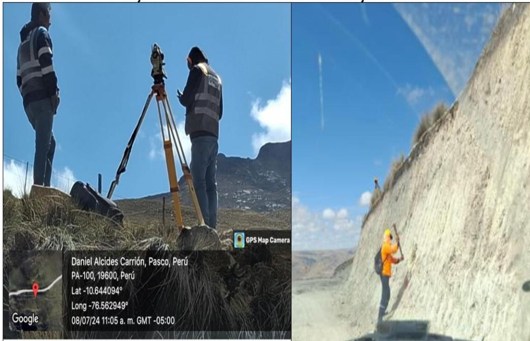
Asimismo, se pudo constatar que se viene realizando trabajos topográficos de trazo y replanteo con estación total, y colocación de progresivas.
