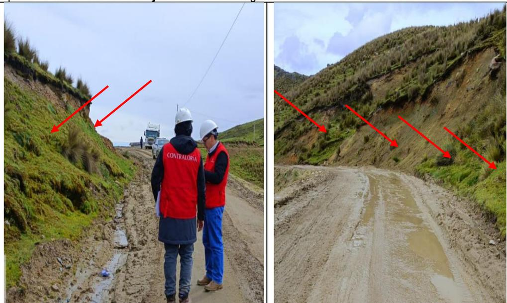
Tramo comprendido entre la progresiva **0+420.00** hasta la progresiva **0+540.00**, se puede evidenciar que **no se han realizado trabajos de corte** a lo largo del tramo.
