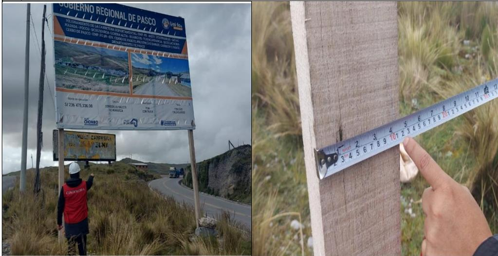
Medición Realizada a los parantes del Cartel de Obra ubicada al final de la vía km 56+430.17, obteniéndose una medida de **3.5 pulgadas x 4.5 pulgadas o 8.90 centímetros x 11.43 centímetros**, material que difiere del parante de madera redondo Eucalipto de 6 pulgadas.
