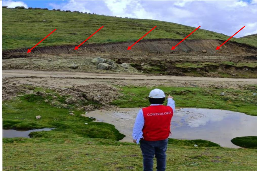
Tramo comprendido entre la progresiva **0+160.00** hasta la progresiva **0+230.00**, se puede evidenciar que **si se han realizado trabajos de corte** a lo largo del tramo.
