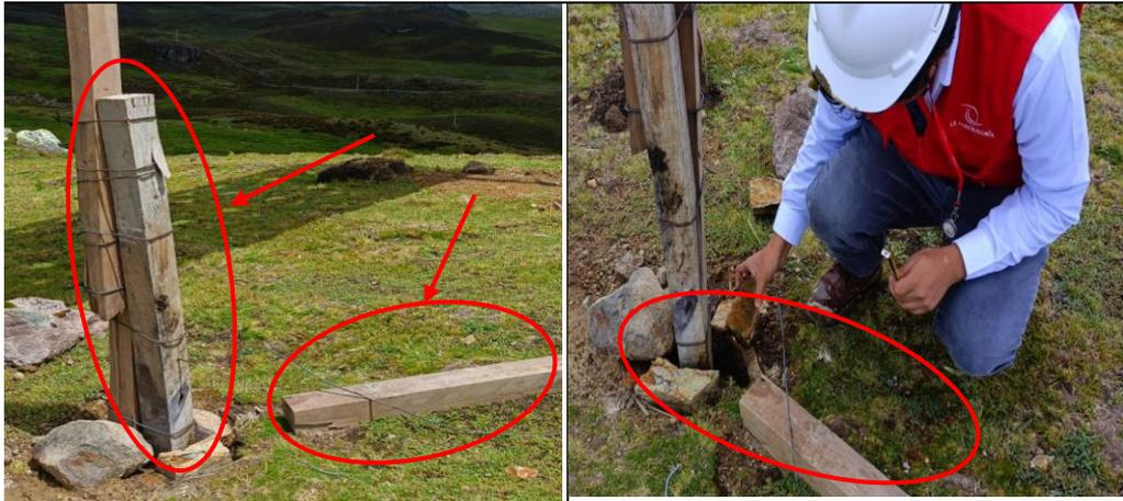
Restos del parante de 3x3 pulgadas colapsado, así como los refuerzos que se colocaron de trozos de madera de 3x3 pulgadas y alambres para mantener a pie el parante que incumple con las especificaciones técnicas.
