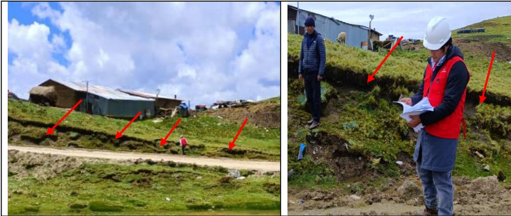
Tramo comprendido entre la progresiva **0+230.00** hasta la progresiva **0+265.00**, se puede evidenciar que **no se han realizado trabajos de corte** a lo largo del tramo.
