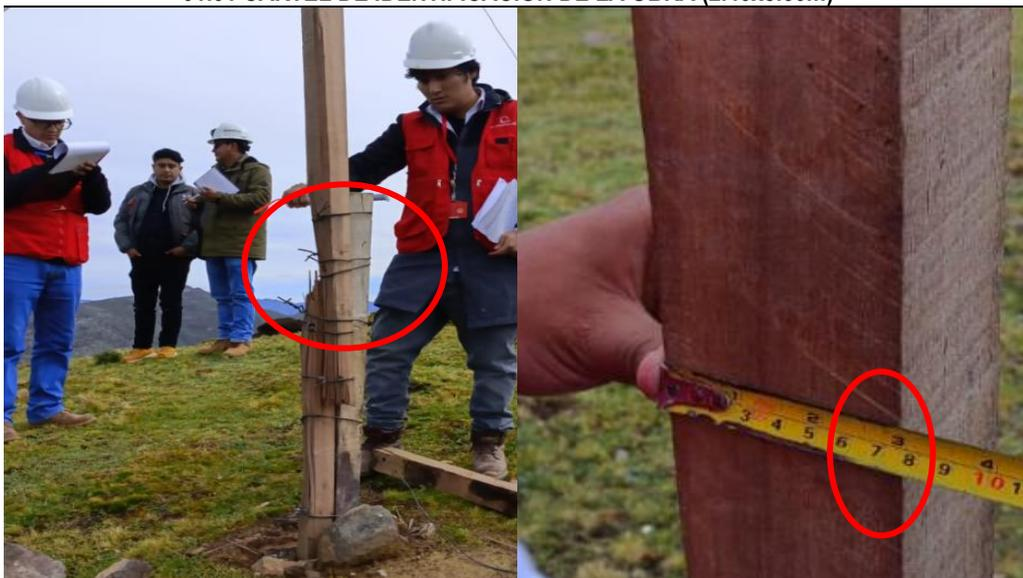
Medición Realizada a los parantes del Cartel de Obra ubicado al inicio de la via km 00+050, obteniéndose una medida de **3 pulgadas o 7.62 centímetros**, material que difiere del parante de madera redondo Eucalipto de 6 pulgadas.
