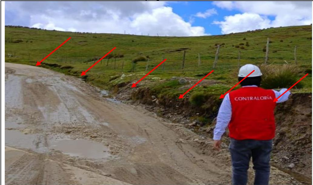
Tramo comprendido entre la progresiva **0+000.00** hasta la progresiva **0+160.00**, se puede evidenciar que **no se han realizado trabajos de corte** a lo largo del tramo.
