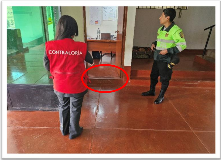
Imagen n° 6 Acceso a la Zona de Atención al Público, cuenta con obstáculo, para su libre acceso a personas con discapacidad
