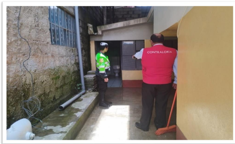
Imagen n.° 8 Los servicios higiénicos se encuentran distantes al área de atención al público
