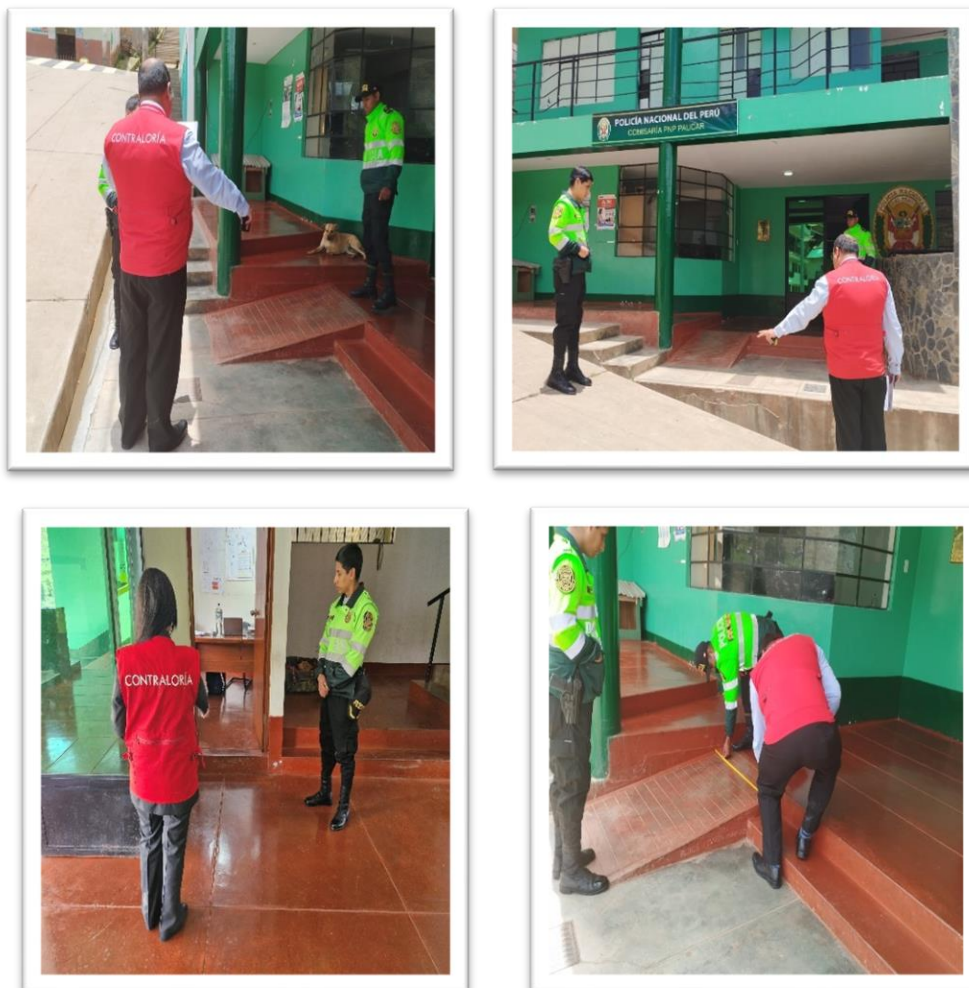
Imagen n.º 2, 3, 4 y 5 Rampa de Acceso, Ingreso desde la Acera, ancho de la rampa y no se cuenta con medios mecánicos que permitan el acceso a la Comisaría
