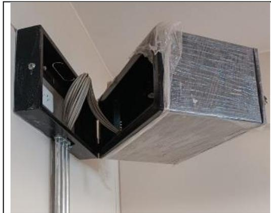
**Descripcion:** En el area de Material Didáctico del 2do y 3er piso (lado izquierdo y derecho) se verificó que existen las conexiones de cables de red, sin embargo, se verificó que no existe dentro del gabinete un switch o conmutador (dispositivo de interconexión utilizado para conectar equipos en red) Faltando 4 de estos equipos
