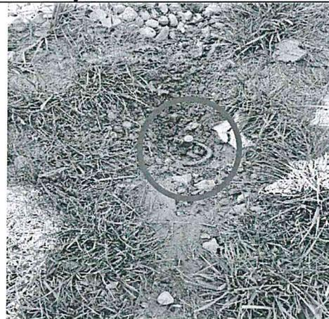
**Descripción:** Se observa la varilla de cobre, el conductor de cobre sin protección alguna en tres (3) puestas a tierra en la parte posterior del ambiente de media tensión
