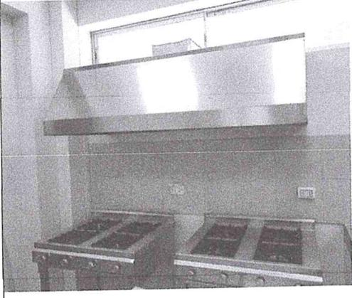
**Descripción:** Cocina ubicado en el tercer nivel sin sistema de extracción de humo y vapores de grasa.
