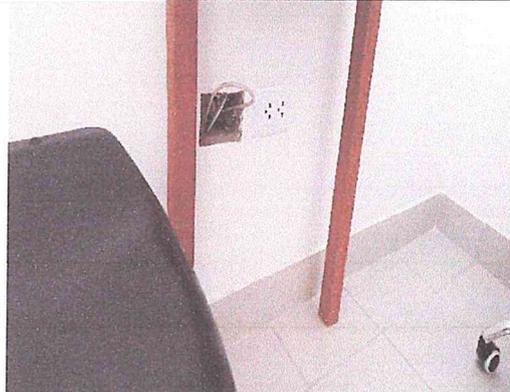
Se verifico que en la Oficina Auxiliar del 1er piso falta colocar la toma internet RJ 45, verificandose el cable de datos expuesto
