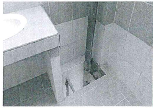
3er nivel, baño de damas, falta de protección en ducto
