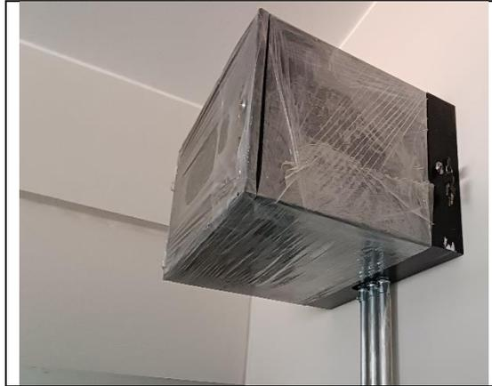
**Descripción:** En el área de Material Didáctico del 1er, 2do y 3er piso (lado izquierdo y derecho) se verificó que existen las conexiones de cables de red, sin embargo, se verificó que no existe dentro del gabinete un switch o conmutador (dispositivo de interconexión utilizado para conectar equipos en red) Faltando 6 de estos equipos
