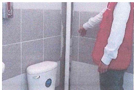
Se observa el servicio higiénico para discapacitados del módulo piscina no cuentan con barras de apoyo tubulares y falta de cobertura de la tubería.
