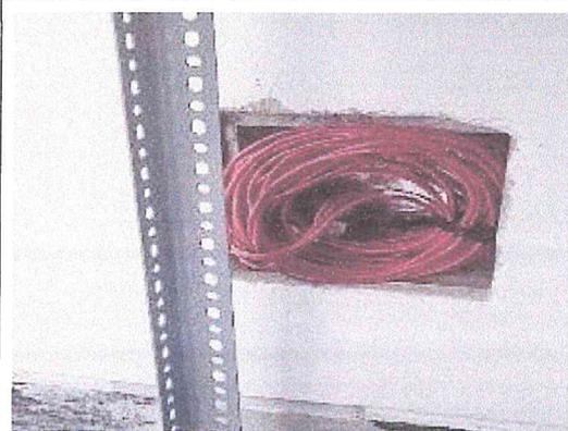
Almacén de carpintería 1er piso módulo talleres, cables eléctricos expuestos
