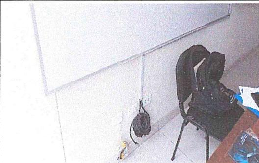
En el Aula 206 C se verificó la pizarra arqueada y el punto de red sellado con tapa ciega y el cable de red sobresaliente, faltando la instalación de toma de internet RJ45
