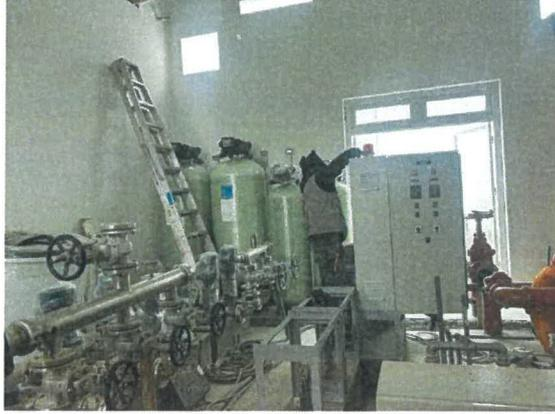
Se constató la instalación parcial de las bombas, las cuales no fueron valorizadas porque no se realizaron las pruebas, sin embargo, de la revisión documentaria se constató problemas con el suministro de agua, ya que la empresa prestadora del servicio de agua potable no cuenta con la presión necesaria (12PSI) ni con la continuidad del servicio (solo 12 hrs/día).
