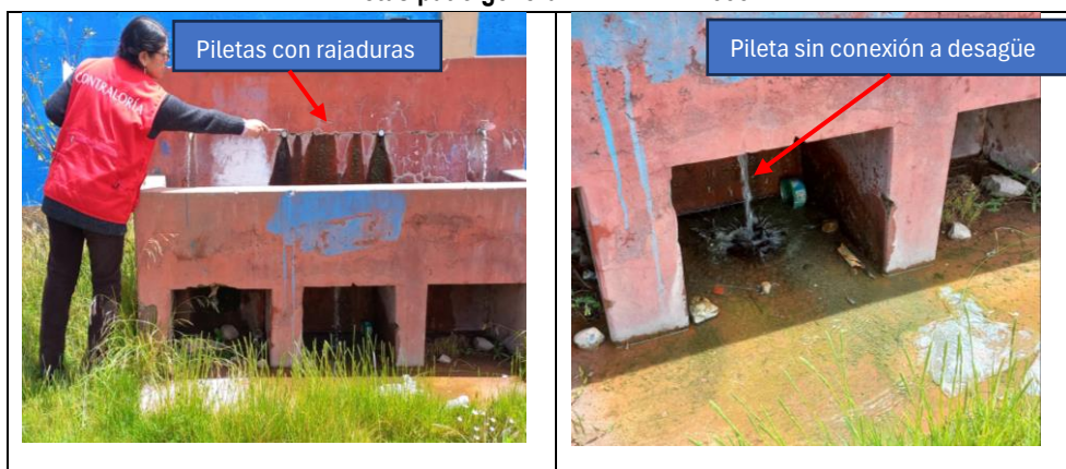
Imagen n.º 12 Piletas patio general – IIEE n.º 72338
