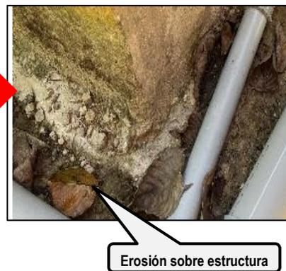
Se evidencia que los diámetros utilizados de las tuberías son distintos, tuberías presentan calentamiento para empalmes, erosión sobre la estructura de la captación.
