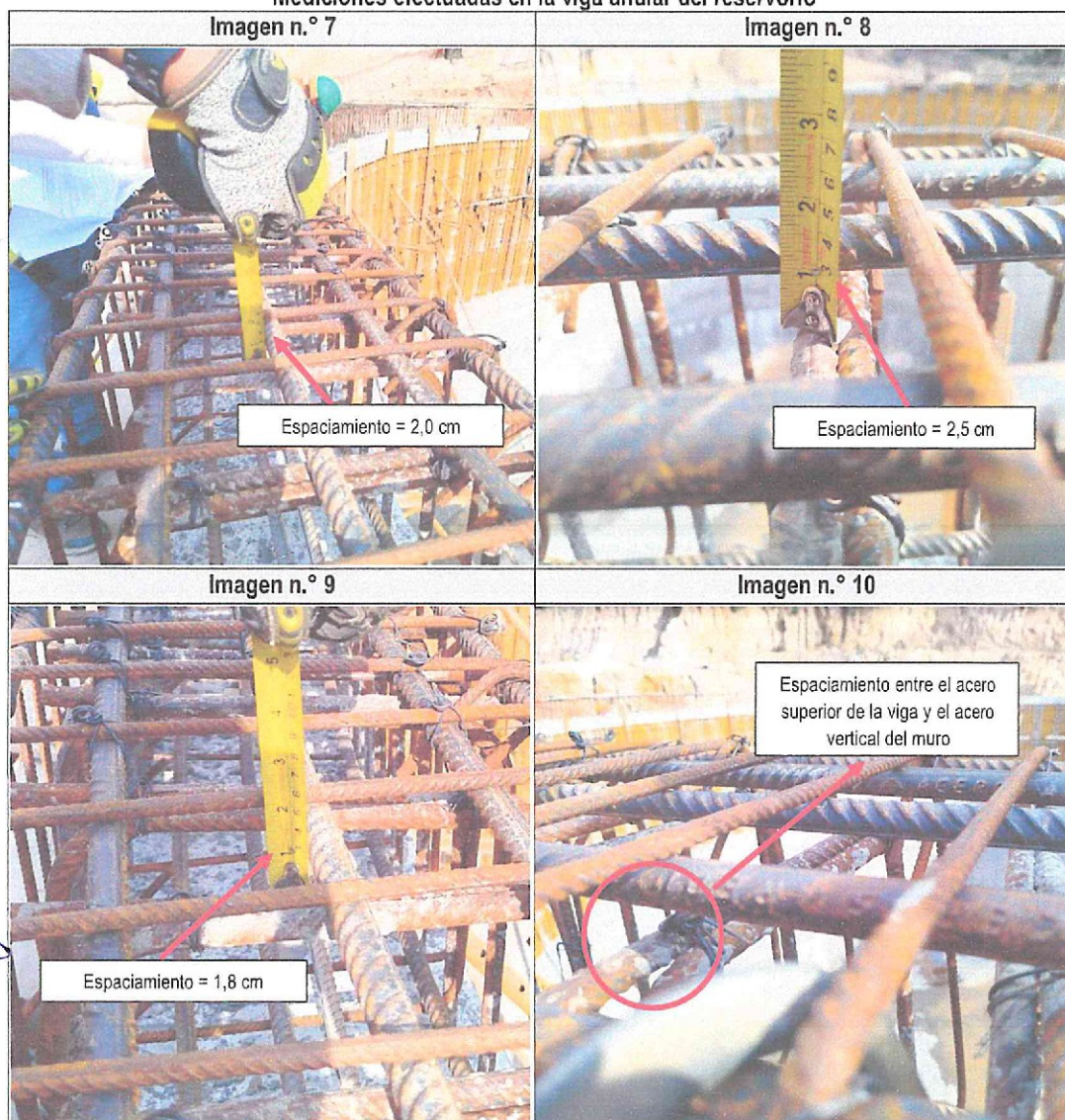
Imagen n.º 7, 8, 9 y 10 Mediciones efectuadas en la viga anular del reservorio
