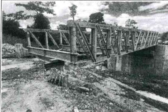
Se evidencia haberse ejecutado trabajos de estribos, rellenos y el montaje de la estructura metálica modular del puente Óvalo (progresiva km 01+871.50).
