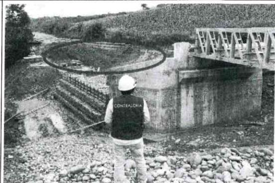
Se evidenció el muro de gavión y el encofrado del cuarto nivel para protección del puente Óvalo
