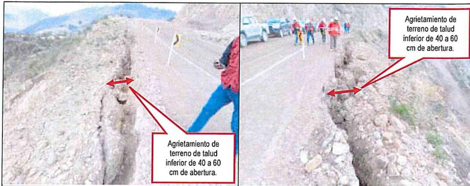
**Imagen n.ºs 5 y 6:** Se evidencia agrietamiento del talud inferior de carretera con aberturas de hasta 40 a 60 cm de ancho, en la progresiva Km 15+800, situación que pone en riesgo a la plataforma de rodadura y partidas ejecutadas por el contratista.
