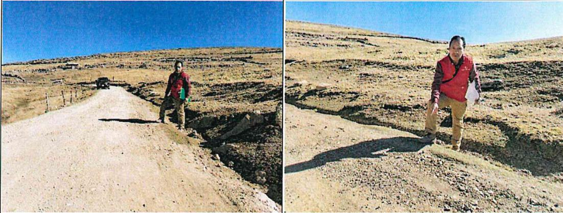
**Imagen n.º 1 y 2:** Se evidencia la actividad de bacheo Prog. Km 0+500 – Prog. Km 0+520, la cual se ha realizado con material tipo cascajo, el mismo que no tiene la misma característica del afirmado, así mismo, no se tiene el nivel de compactado requerido, por lo que el material es inadecuado para la actividad.
