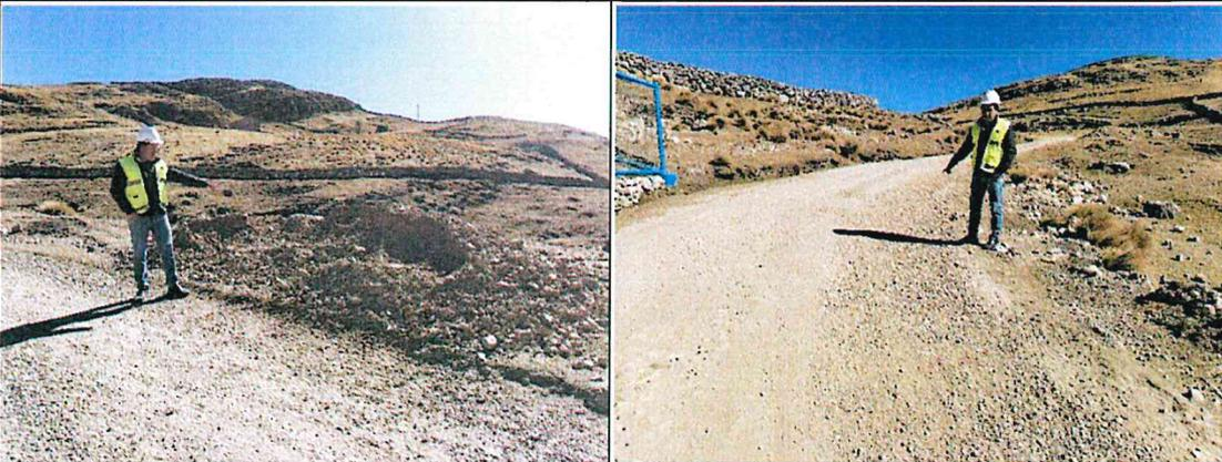
**Imagen n.º 3:** Material tipo cascajo acopiado en las coordenadas 518 665E, 8 577 719N que viene siendo utilizado en la actividad de bacheo, siendo inadecuado su uso para la actividad citada.
