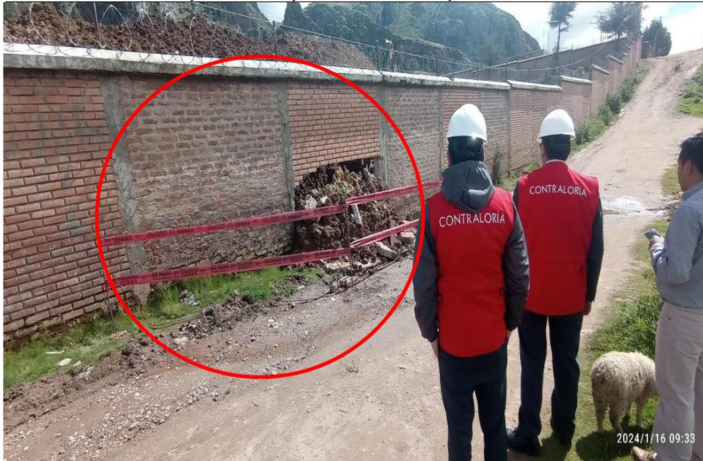
**Comentario:** En la fotografía se observa el colapso de un paño del muro del cerco perimétrico del campus de la UNH a causa del deslizamiento del material excedente y de demolición dispuesto en la zona contigua.
