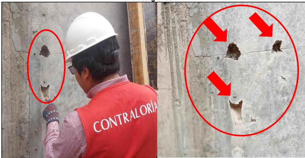
**Imágenes n.°s 16 y 17:** El muro de concreto tipo II ubicado en el lado posterior del Laboratorio General de la Universidad Nacional de Huancavelica, presenta cangrejas de concreto en algunas partes y secciones de la pantalla del muro.
