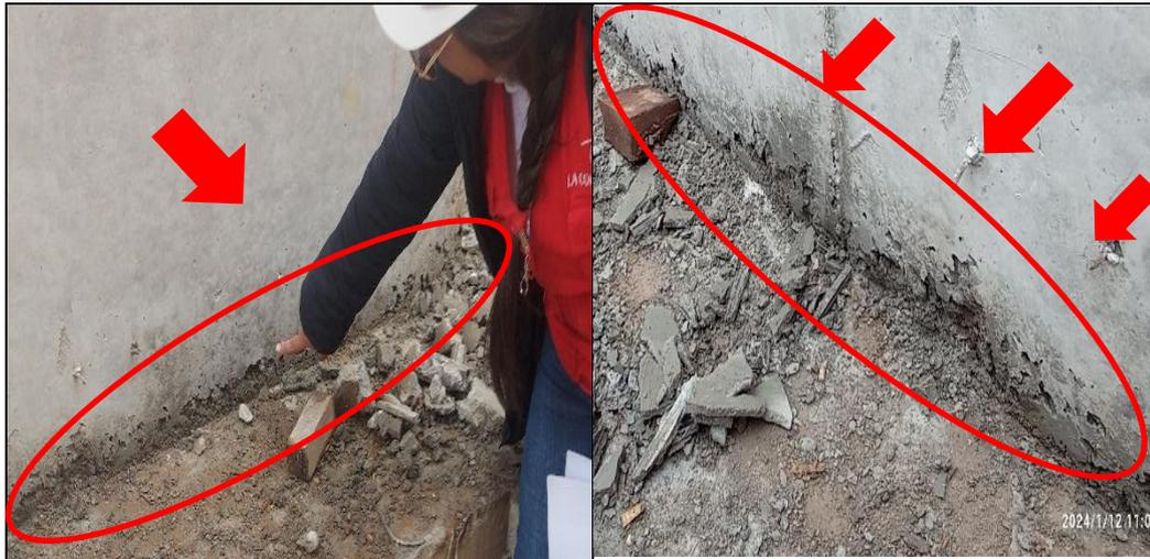
**Imágenes n.ºs 20 y 21:** El muro de concreto tipo II presenta cangrejeras y segregación de concreto en la parte inferior de la pantalla del muro.
