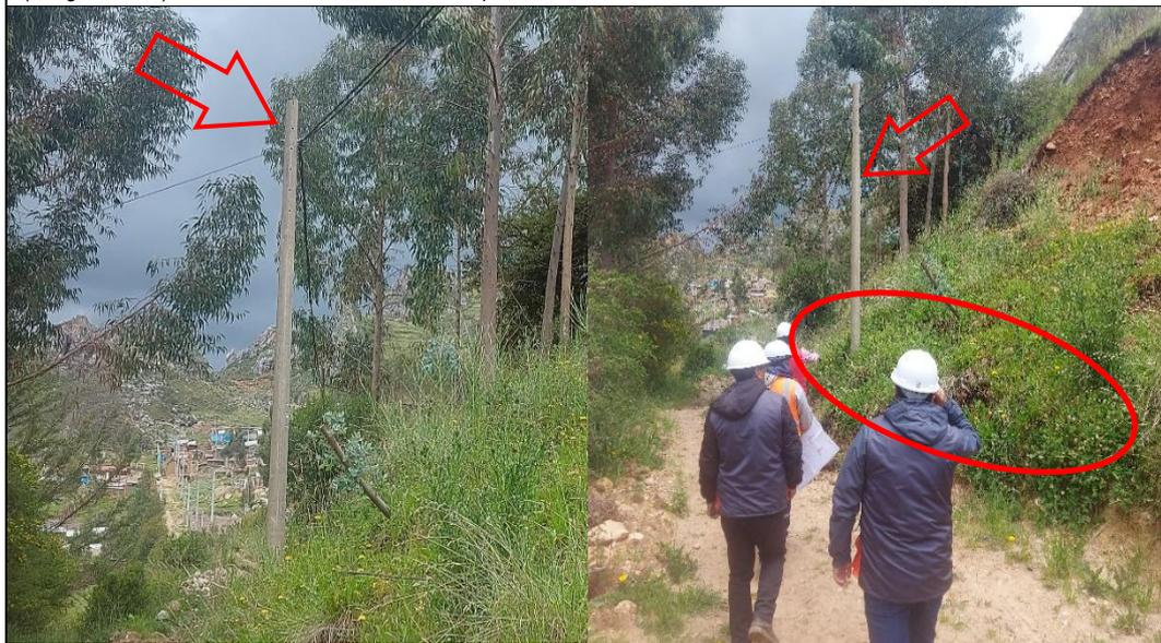
**Imágenes n.ºs 14 y 15:** De la inspección física realizada a dicha zona, el 12 de enero de 2024, se evidenció postes de cableado eléctrico que interfiere con el muro tipo gavión II (Long=39,67m).
