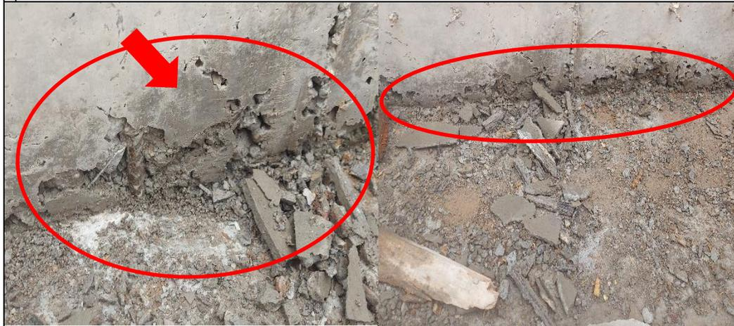
**Imágenes n.°s 18 y 19:** En la parte inferior de la pantalla de muro tipo II de concreto armado, se evidencia cangrejas y segregación de concreto en algunas partes y secciones.
